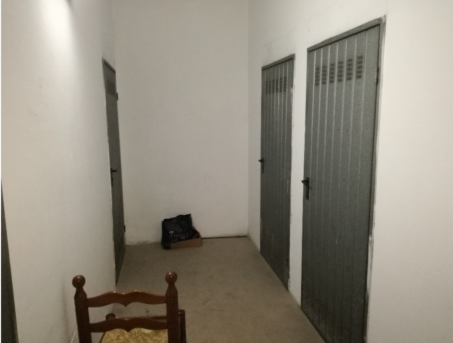
Foto 18: Corridoio di ingresso alla cantinola piano S1
