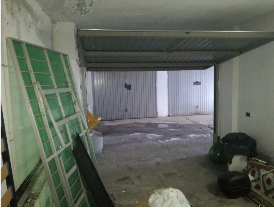
Foto 23: Interno box sub 18
