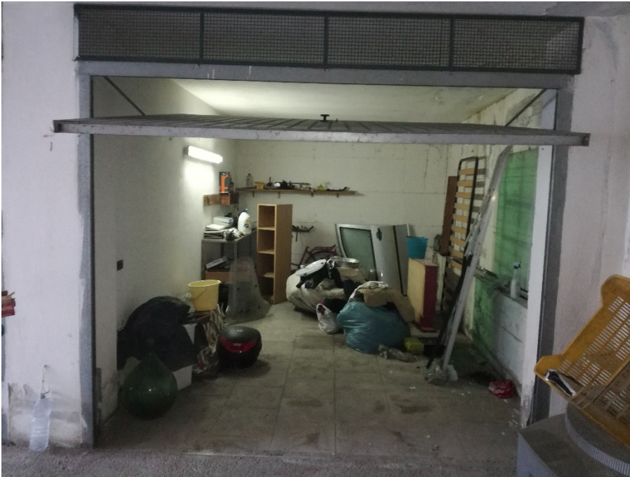
Foto 24: Interno box sub 18
