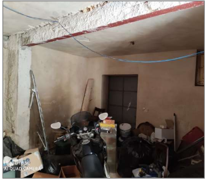
Vista verso il secondo ingresso su via Pastizzaro
