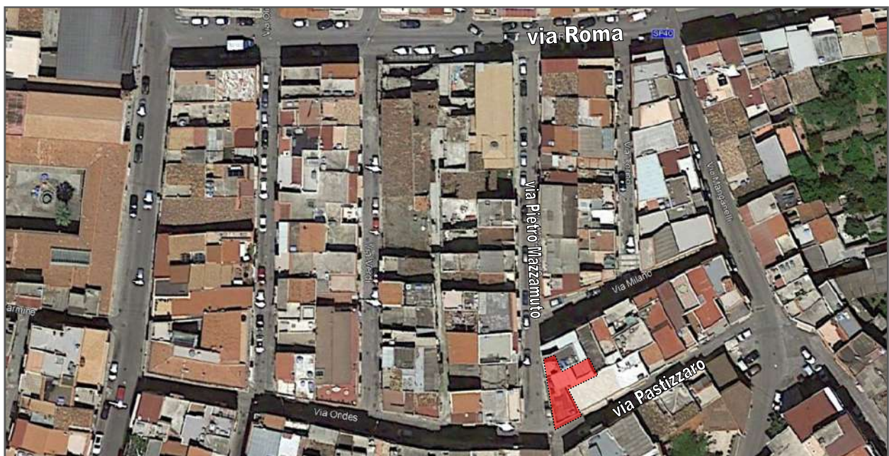
Visione dall'alto della palazzina in cui insiste l'immobile pignorato
