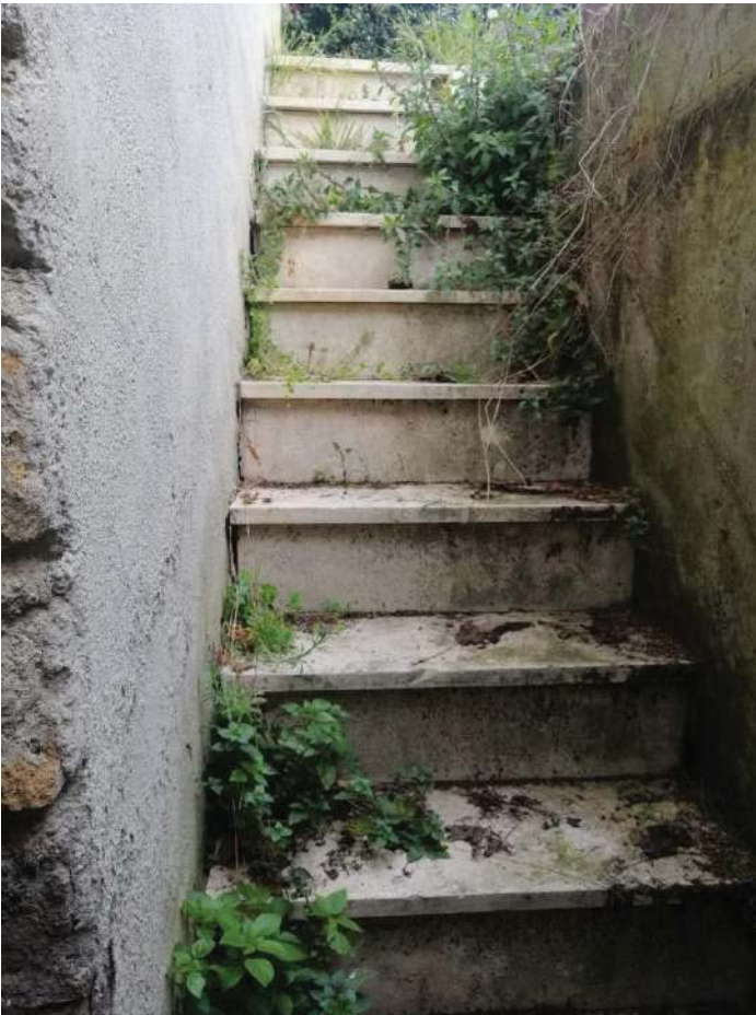
Foto 14 – Scalata Piano Terra/Magazzino
