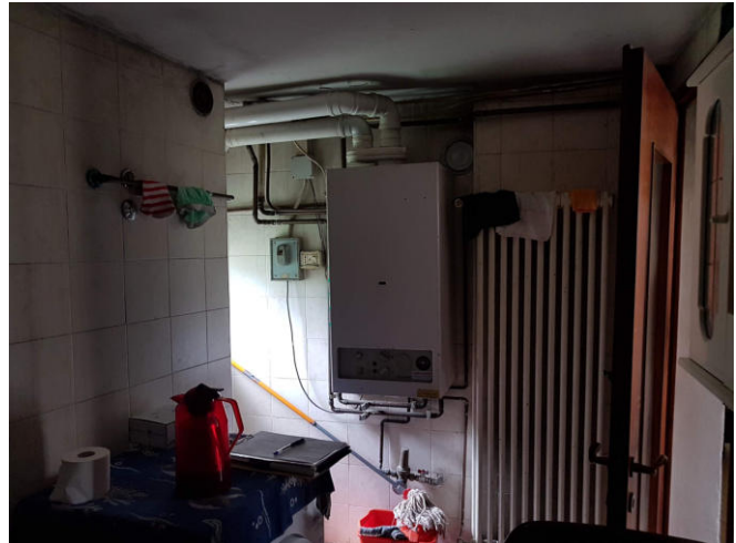
Foto 9: bagno piano terra
