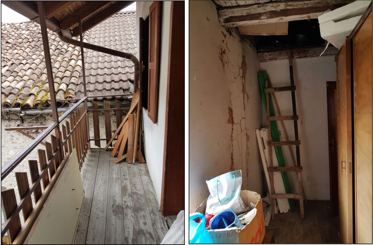
Foto 13 e 14: terrazzo al piano secondo e ingresso con botola al piano terzo
