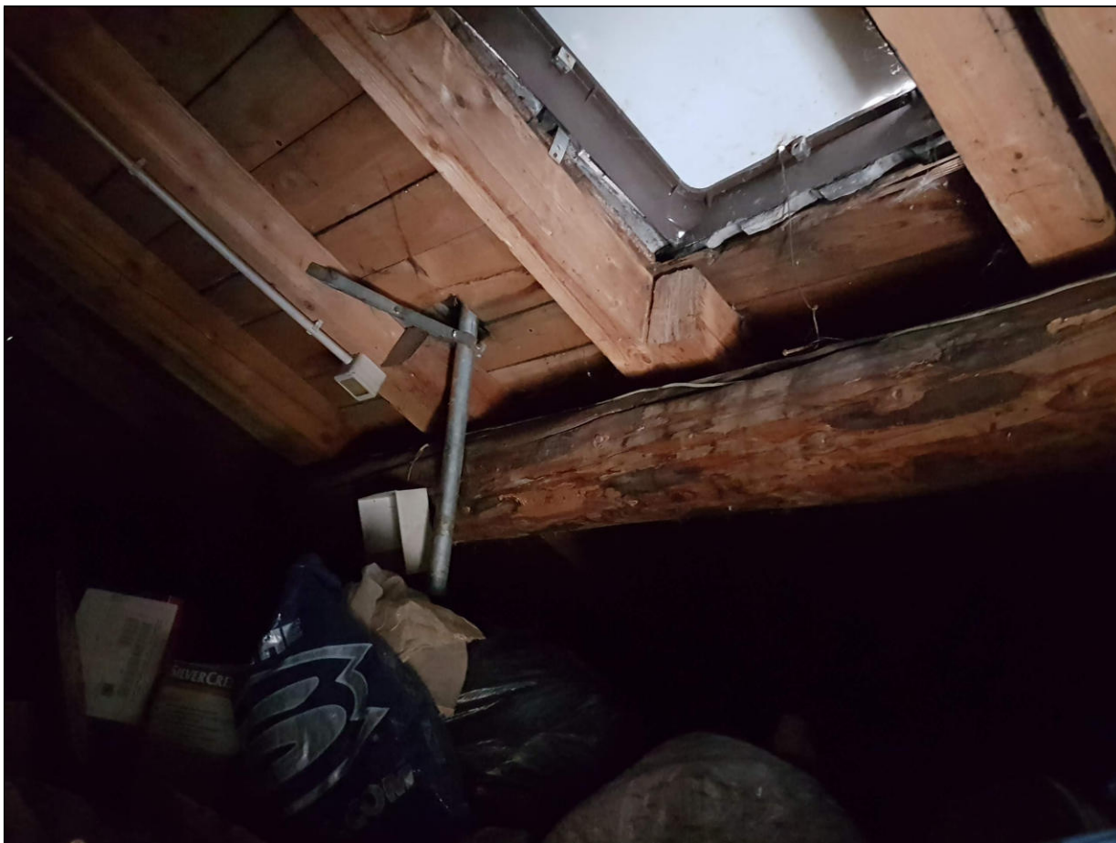
Foto 16: sottotetto non abitabile piano terzo
