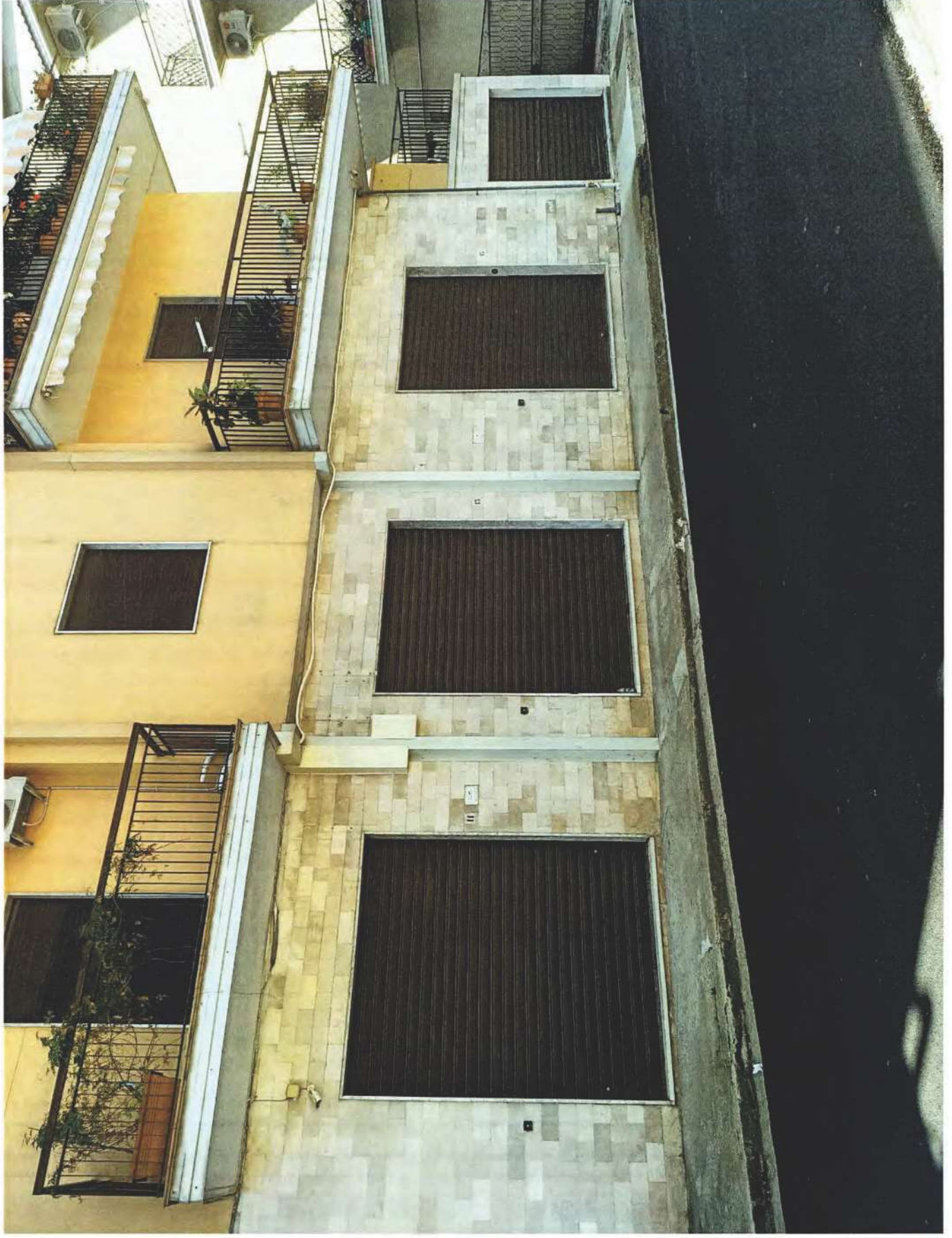
VISTA ESTERNA DI TUTTI I SUB. SU VIA GRAMSCI
