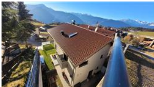
Vista dell'immobile lato nord-est
