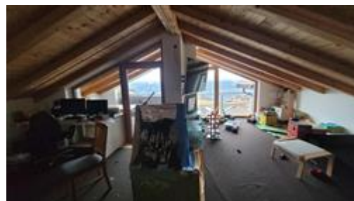
Soffitta al piano secondo
