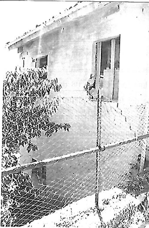
Particolare Prospetto vista da Via S.Ercolano
