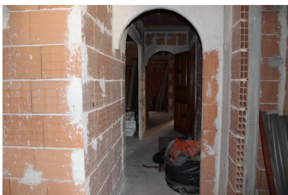
Vista del corridoio
