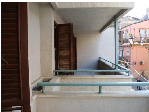
Vista di un balcone
