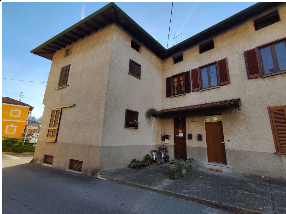
FOTO 3 - Vista ingresso scale comuni dove sono posizionati contatori acqua e corrente Via 24 Maggio n. 37
