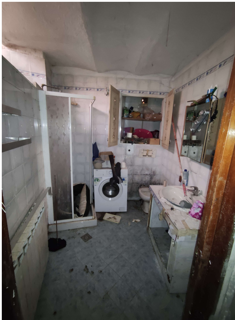
FOTO 7 - Vista interna bagno
