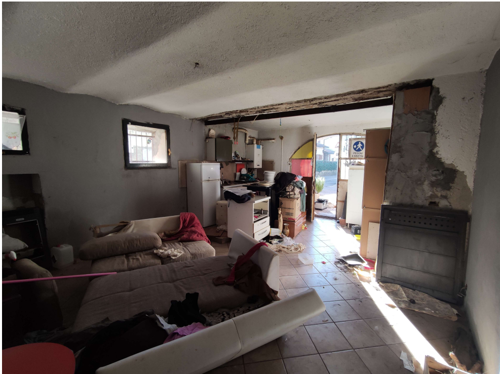
FOTO 5 - Vista interna ingresso-soggiorno
