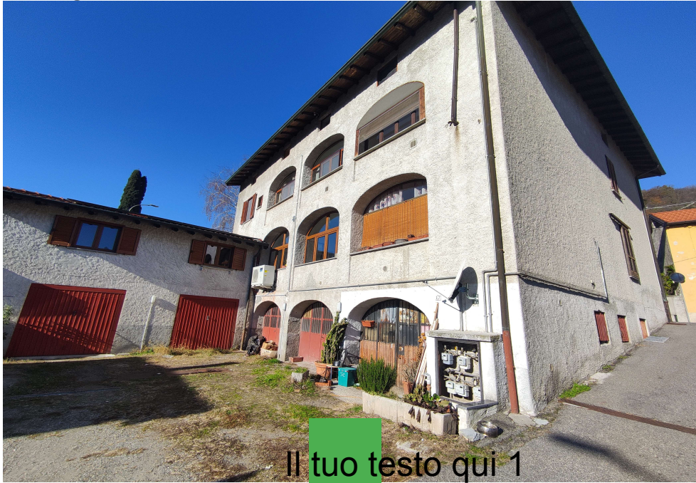
FOTO 1 - Vista ingresso da corte comune Via Marche 17
