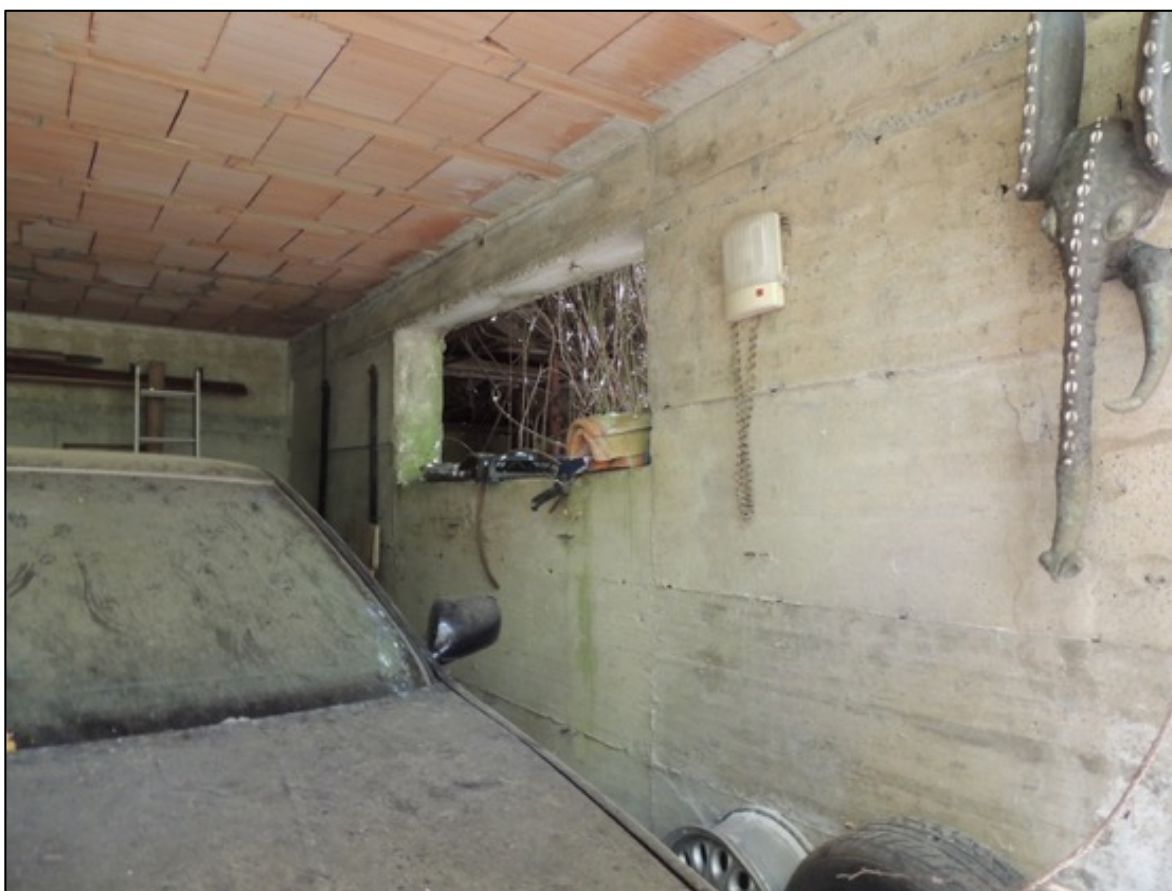
Foto 4 – vista dell'interno del box auto. Nel muro perimetrale di levante è presente una finestra priva di infisso.
