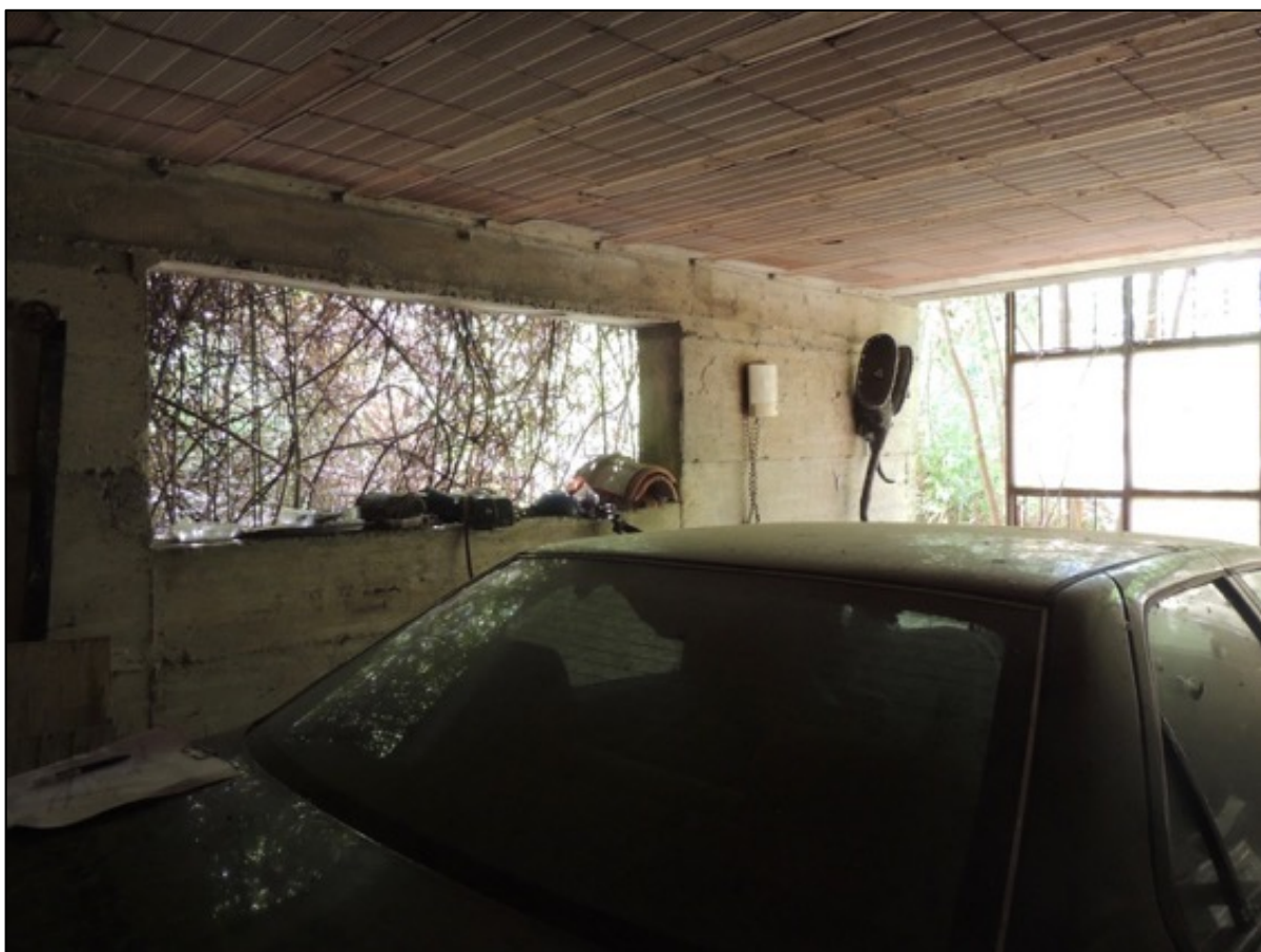
Foto 6 – vista verso sud est del box auto B
