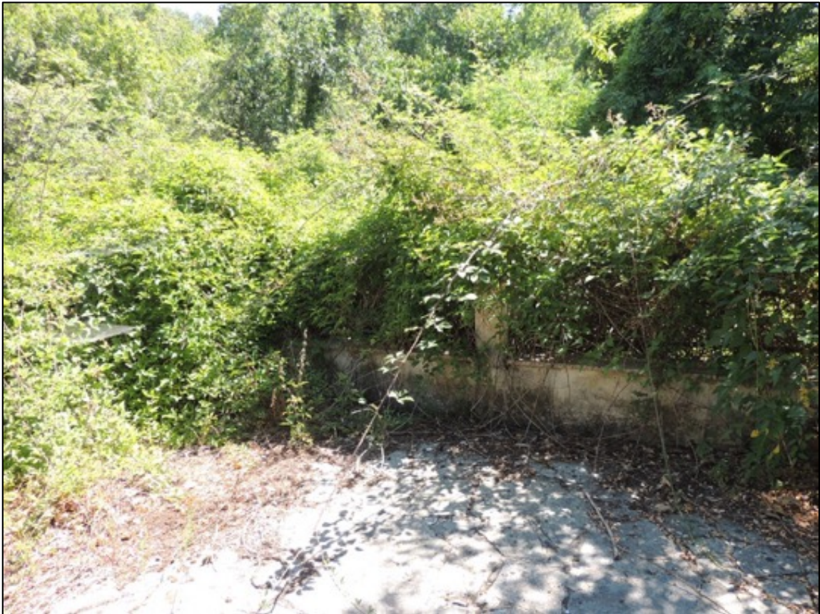
Foto 27 – copertura del box auto B, vista verso nord est (mappale 497)
