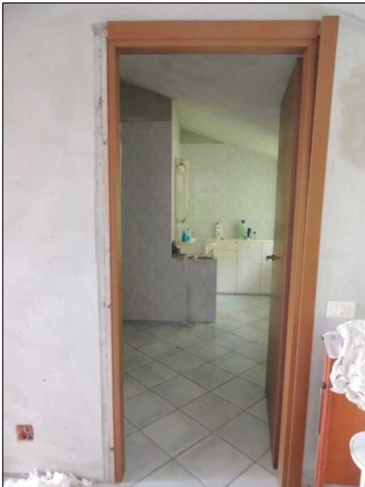
Foto 61 – bagno C visto dal disimpegno B
