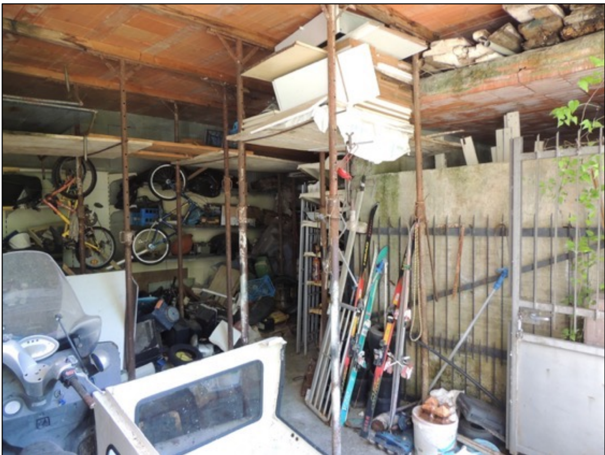
Foto 4 – vista dal cancello, a destra la parete che divide la zona 1 dalla zona 2
