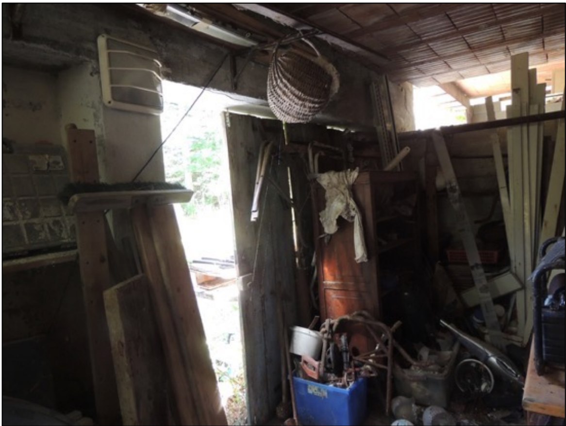
Foto 11 – veduta verso l'esterno della zona 2 del box auto A
