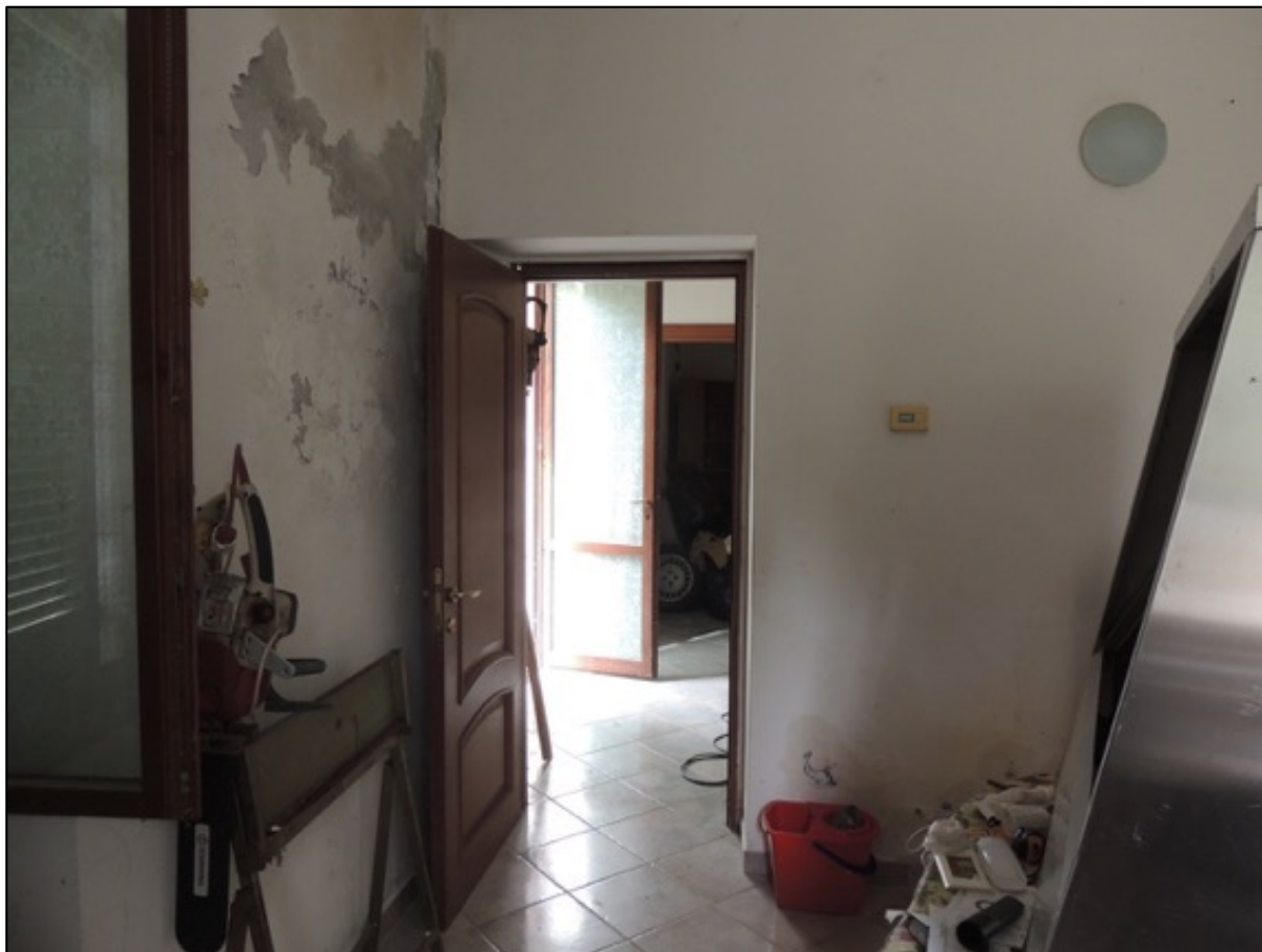
Foto 7 – la cucina, vista verso l'ingresso
