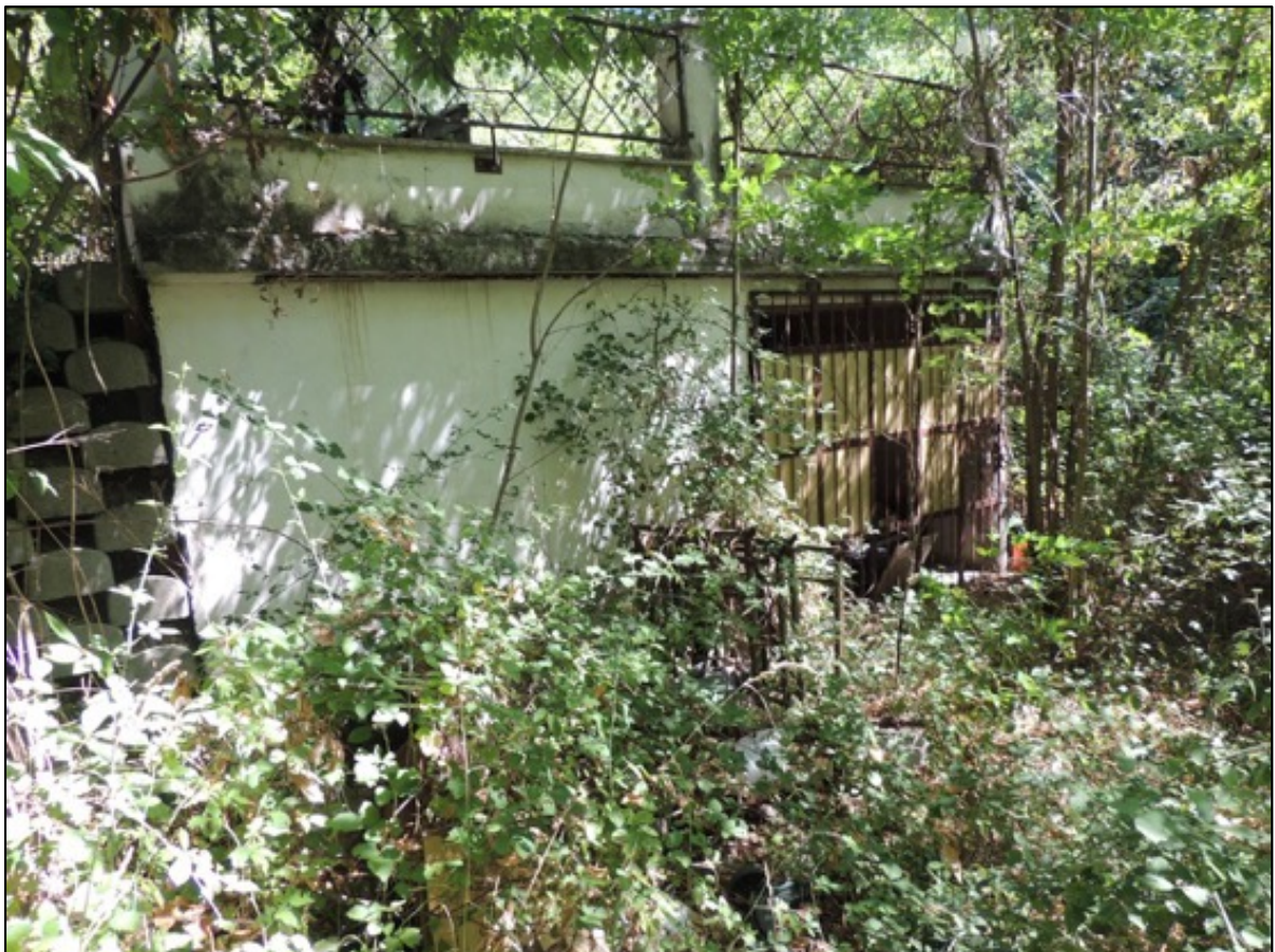
Foto 2 – il volume del box auto, con tetto pensile alla stessa quota altimetrica del cortile; il volume è staccato dal terreno mediante vespaio (a sinistra della foto)
