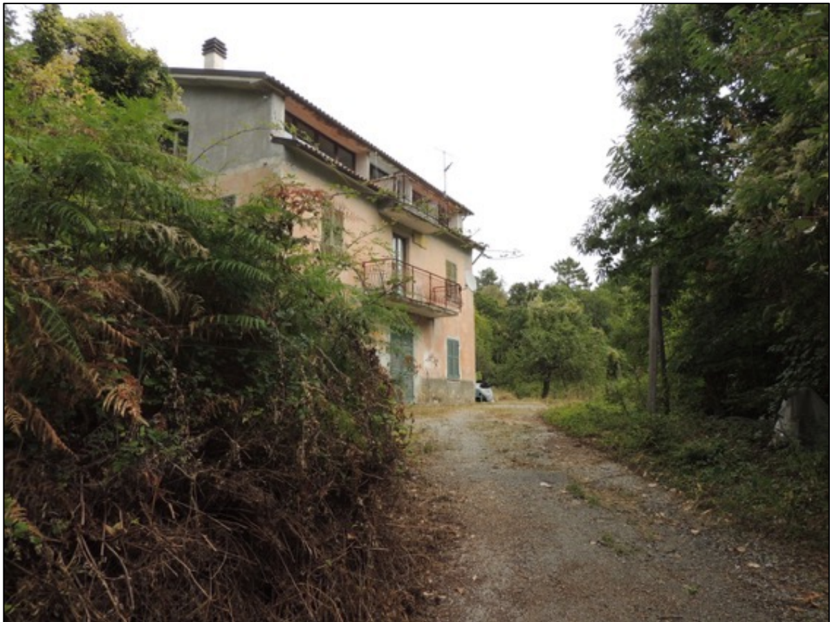
Foto 9 – la strada privata (mappale 501) che conduce al fabbricato
