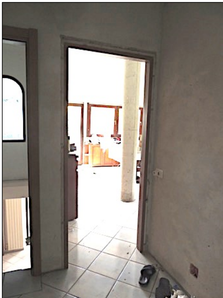
Foto 65 – accesso al soggiorno dal disimpegno B
