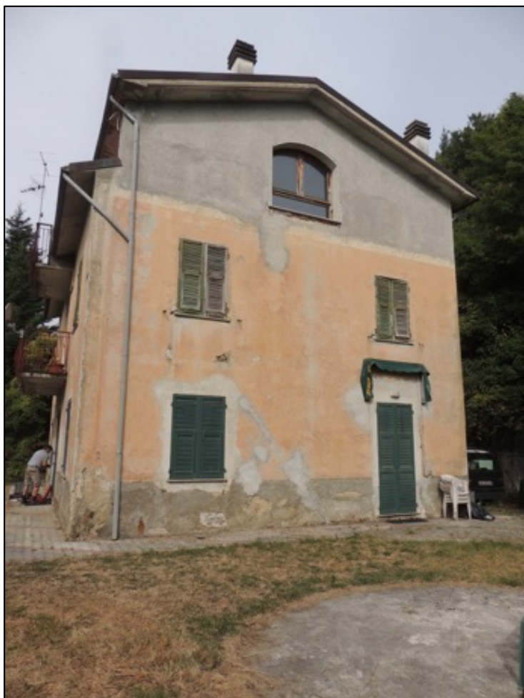
Foto 20 – la facciata est del fabbricato
