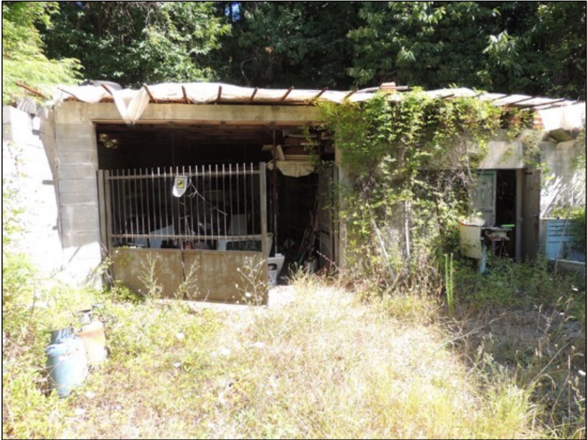
Foto 1 – Box auto A a sinistra cancelli di accesso alla zona 1 e a destra la porta di accesso alla zona 2
