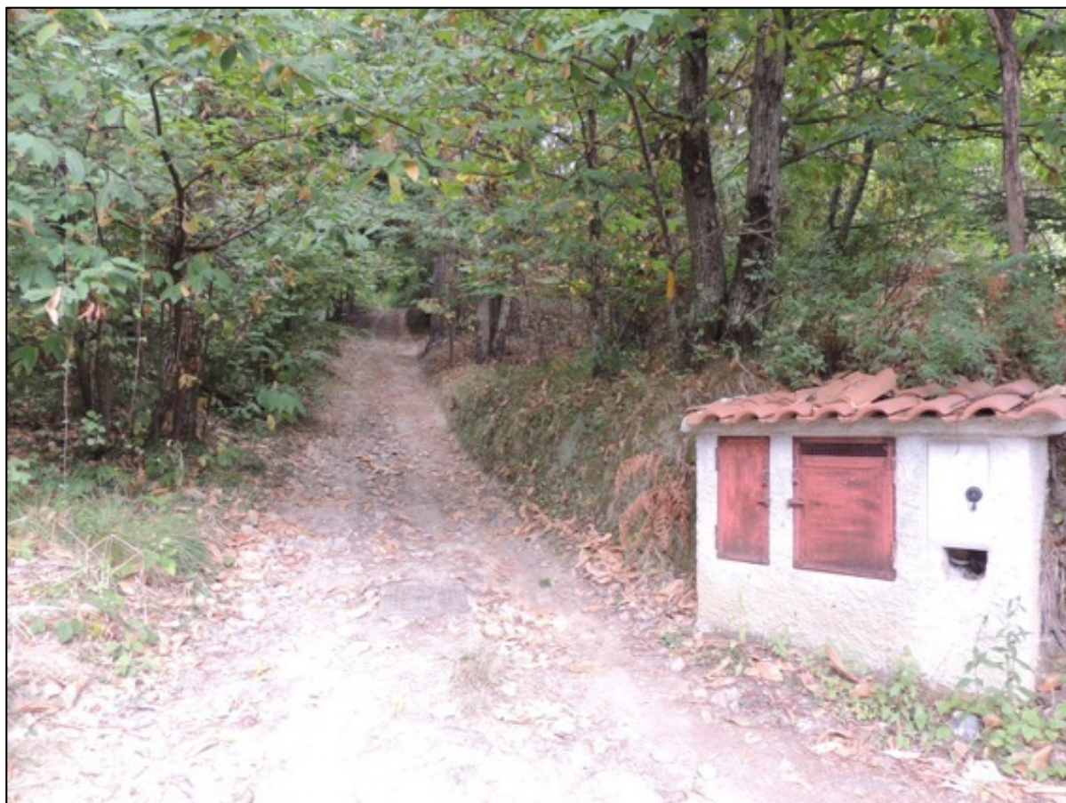
Foto 6 - il sentiero comunale e a destra il volume tecnico contenente i contatori dell'immobile di Isolato Chiosa 3
