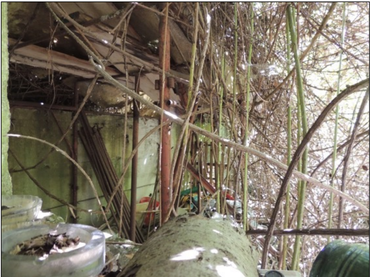
Foto 10 – vista dalla finestra verso l'esterno del box auto B
