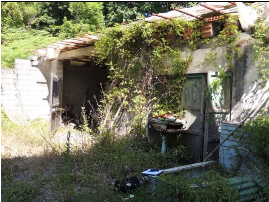
Foto 10 – la porta in legno di accesso alla zona 2 del box auto A
