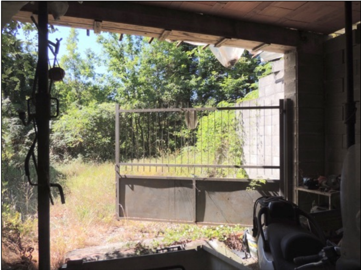
Foto 5 – il cancello grande di accesso alla zona 1 del box auto A
