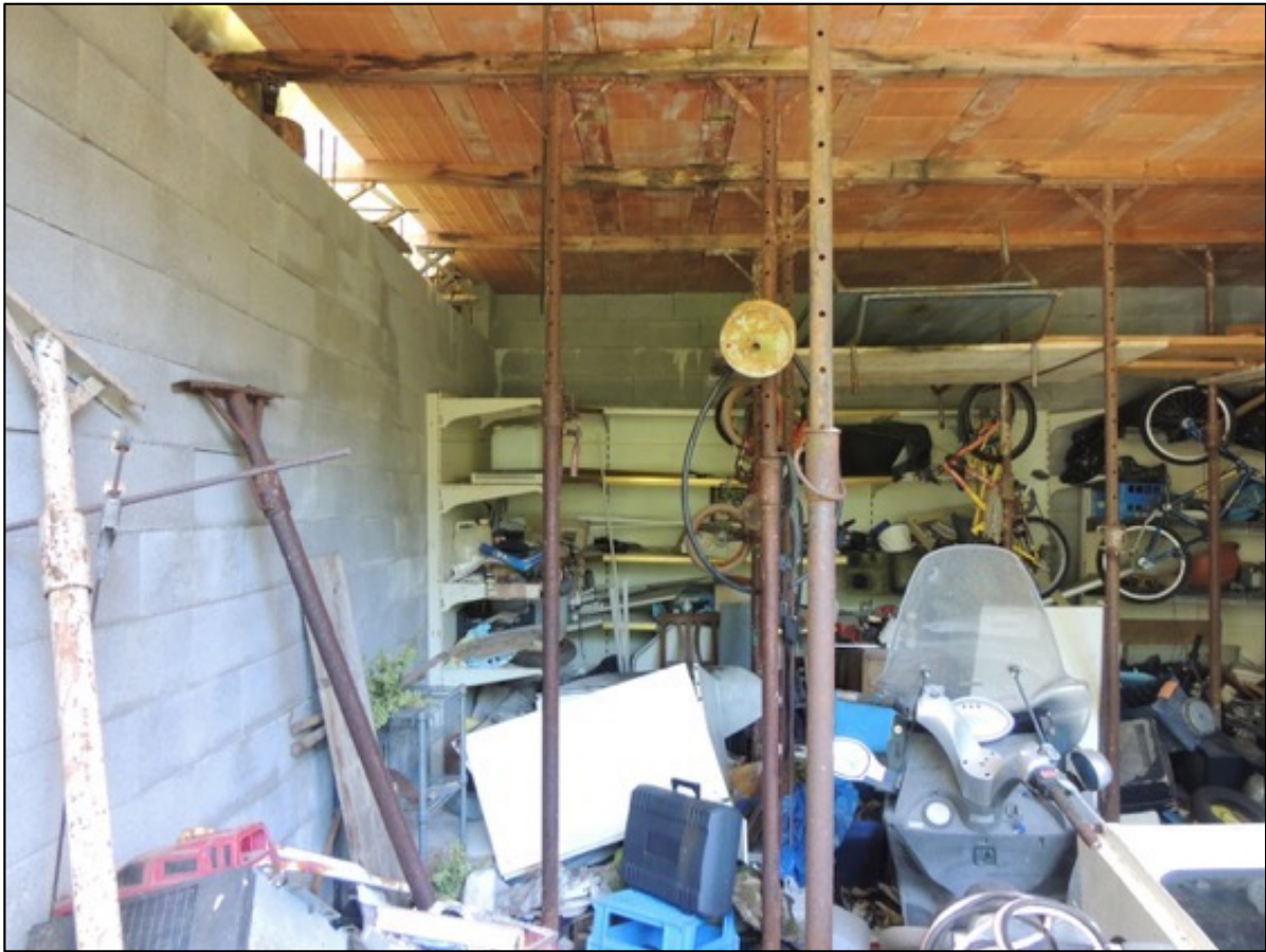
Foto 3 – zona 1 del box auto A vista all'interno dal cancello
