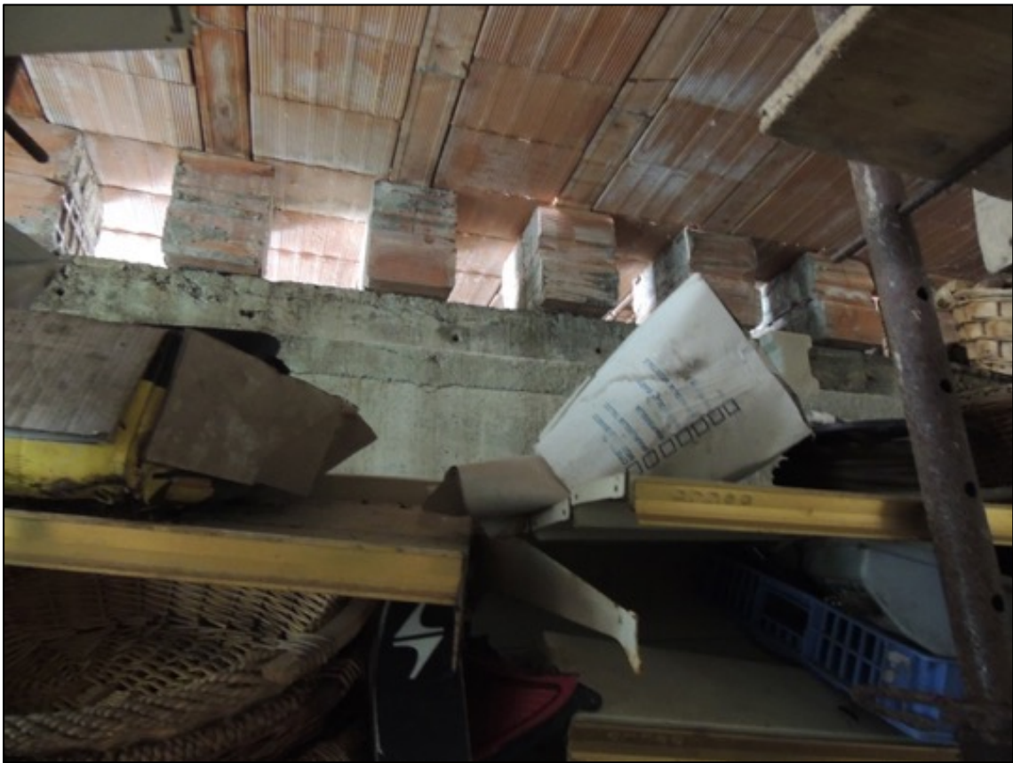
Foto 9 – muro di separazione tra zona 1 e zona 2 del box auto A, dettaglio della copertura
