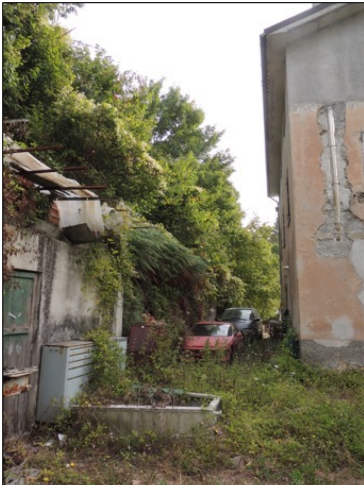
Foto 13 – a sinistra parte dell'auto box e vista del retro del fabbricato; nel distacco tra il fabbricato e il terrazzamento soprastante sono parcheggiate due automobili.
