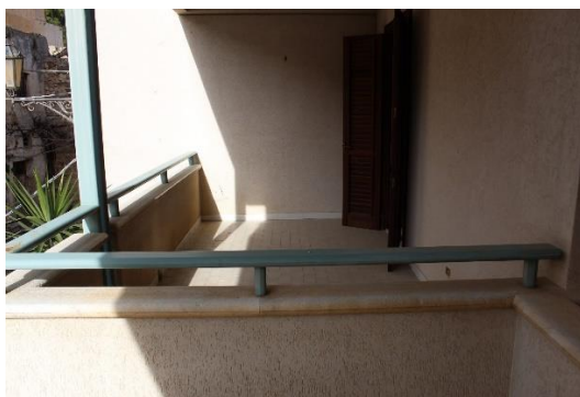
Vista di un balcone
