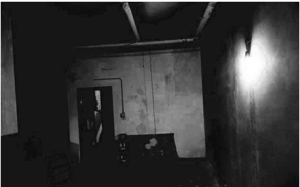
FOTO n°12 – vista del magazzino al piano seminterrato (lotto 3)
