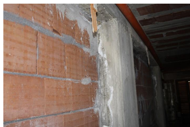
Vista del muro di confine con proprietà Donato
