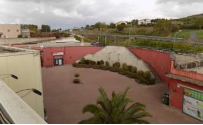
vista d'assieme locale commerciale, pizzeria e scala per accedere al parcheggio in copertura
