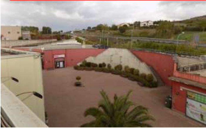
vista d'assieme locale commerciale, pizzeria e scala per accedere al parcheggio in copertura
