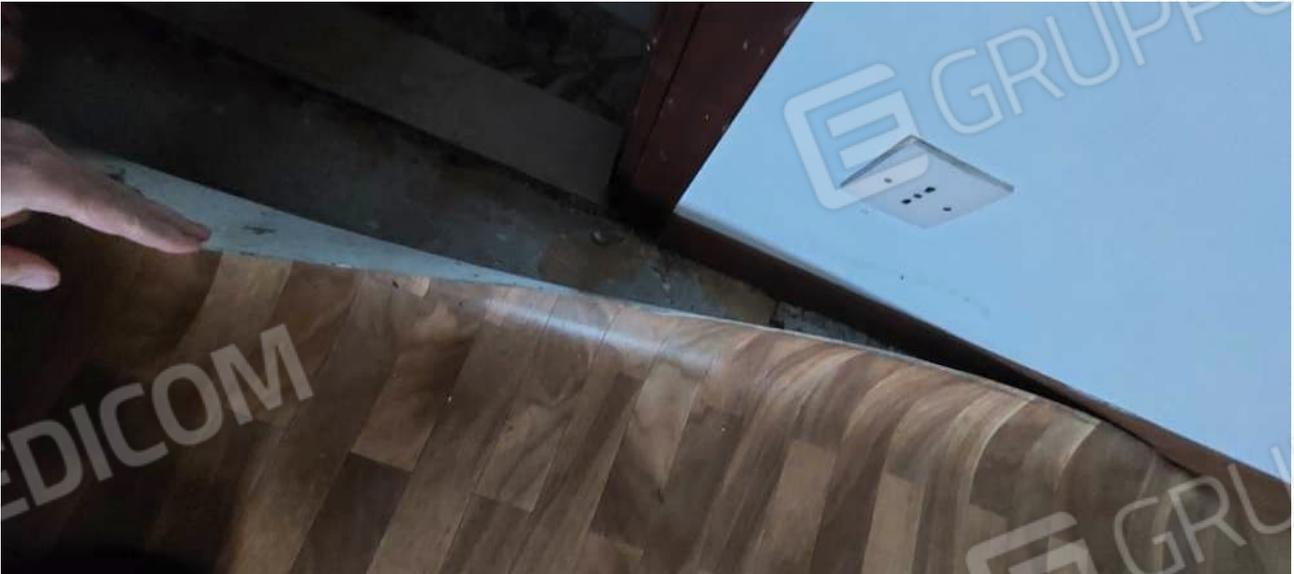
PARTICOLARE DEL PAVIMENTO CON TELO “TIPO” LINOLEUM
