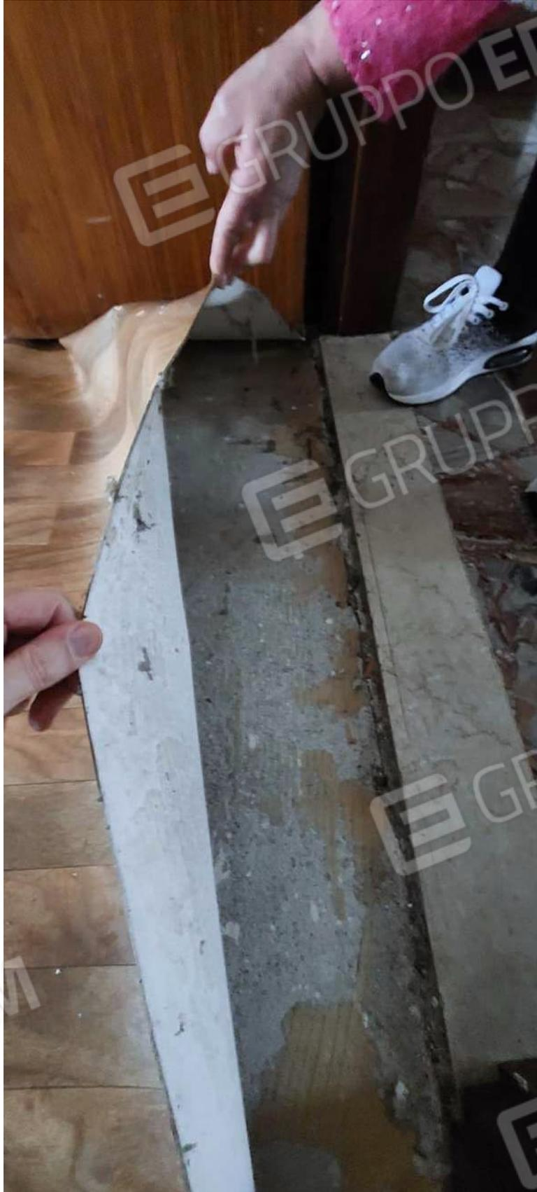
PARTICOLARE DEL PAVIMENTO CON TELO "TIPO" LINOLEUM
