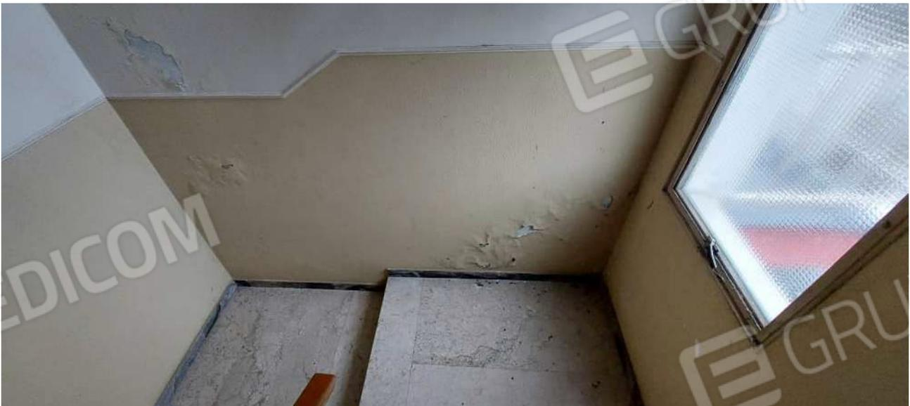
Vano Scala - macchie di infiltrazioni meteoriche
