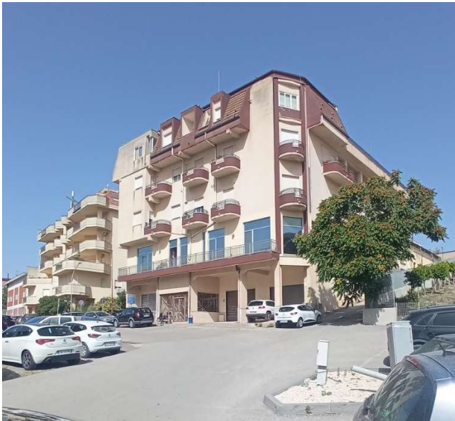
Vista del prospetto via Pablo Picasso
