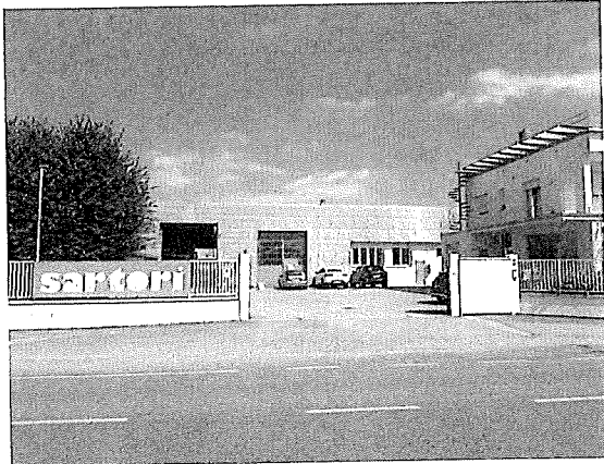
Foto 01: Prospetto Sud fronte strada
