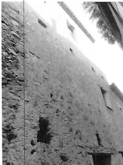
Vista dal retro
