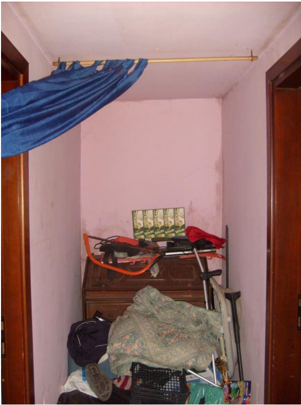
Disimpegno/corridoio (zona dove doveva essere posta la scala a chiocciola di collegamento tra il PT ed il P. Seminterrato)
