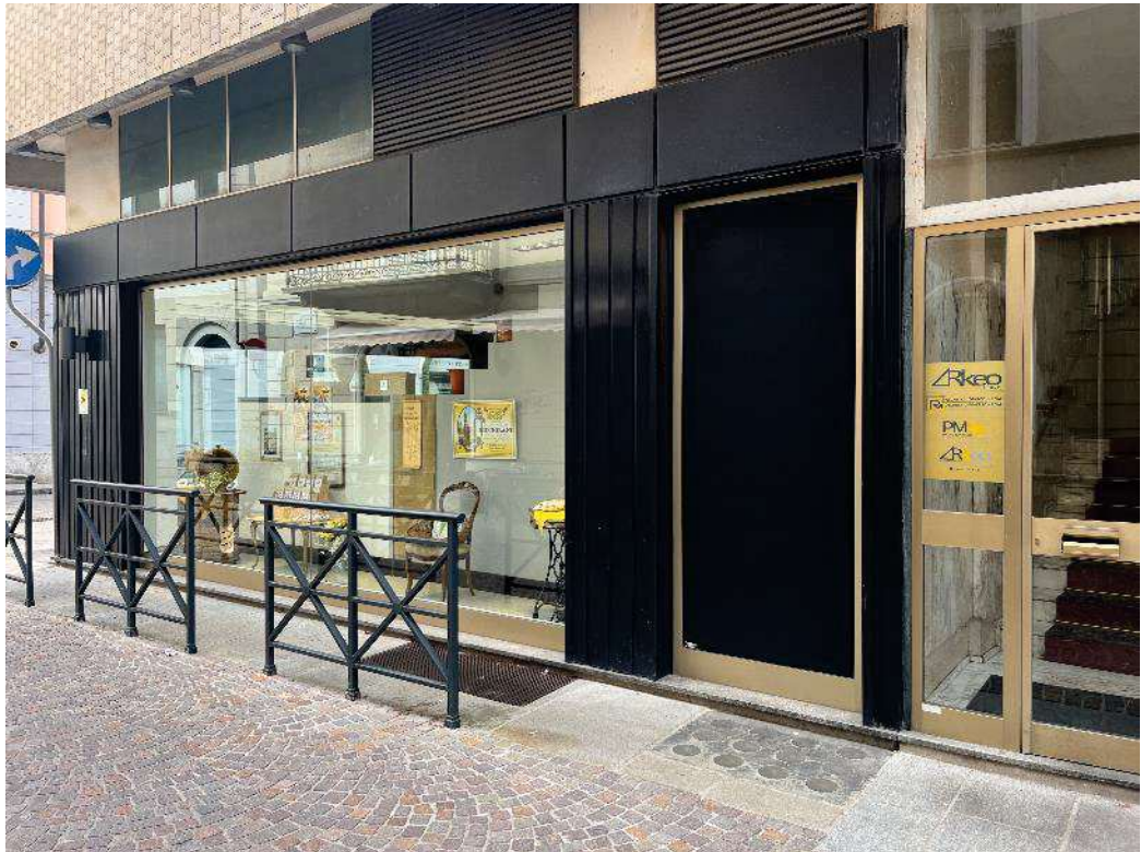
Figura 2: vista della vetrina del negozio dalla via Fratelli Laviny
