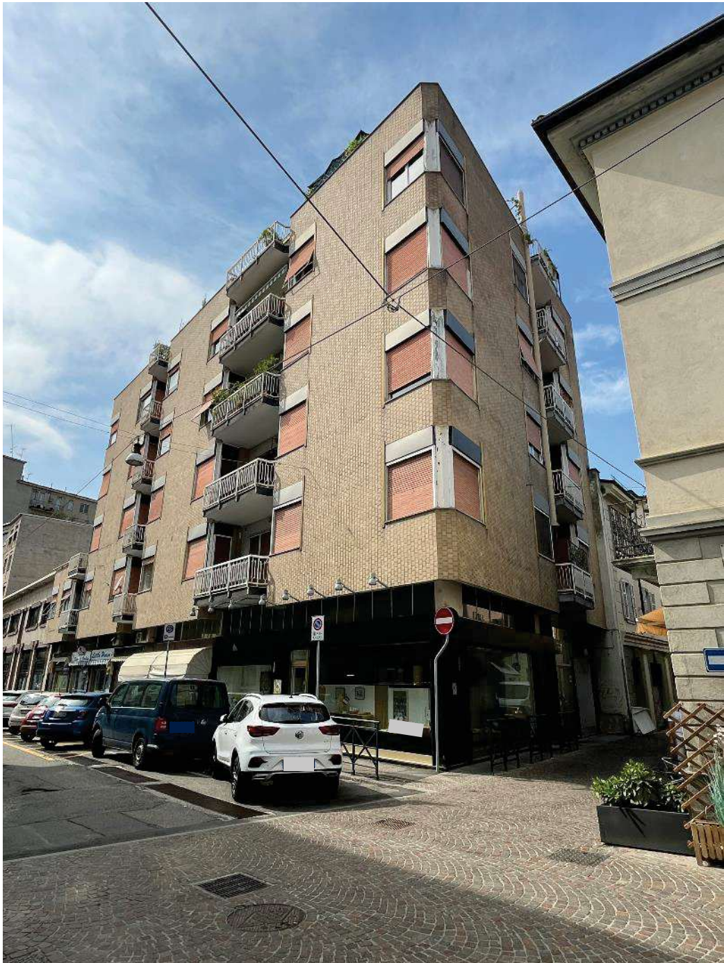
Figura 1: vista del prospetto del fabbricato condominiale
