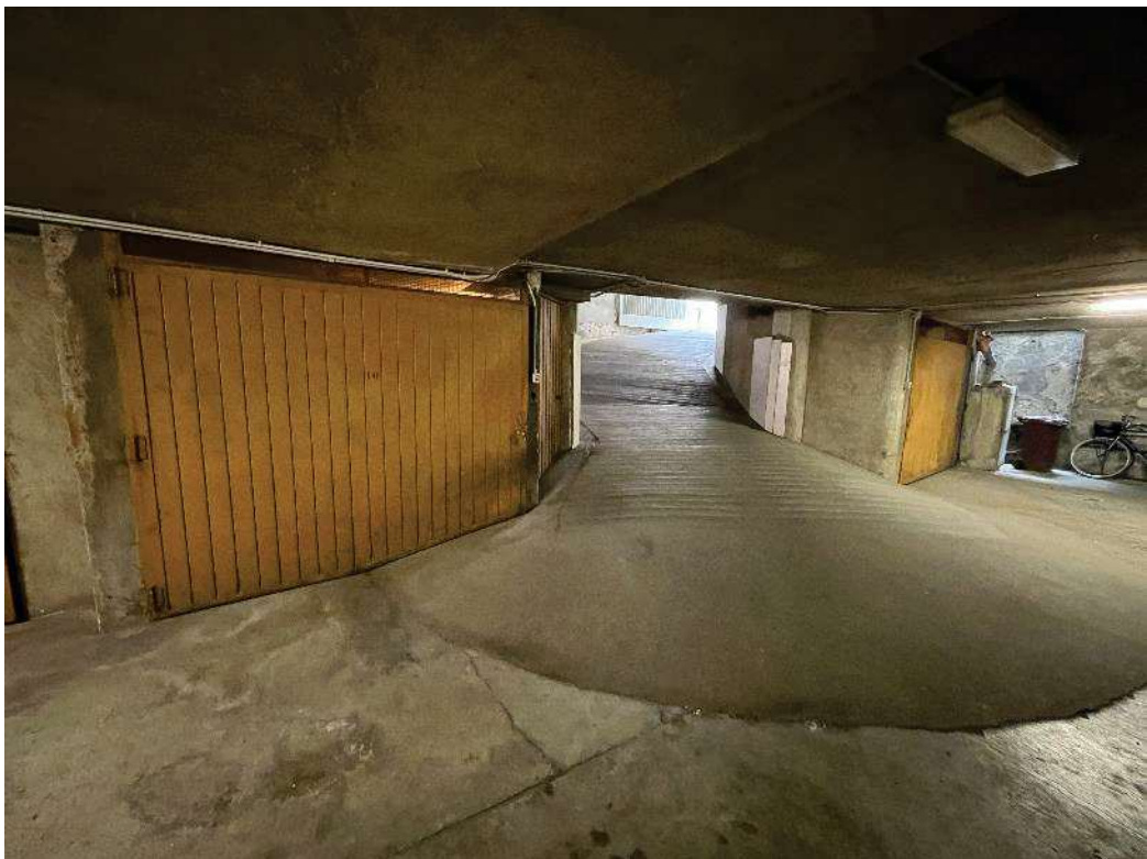
Figura 42: vista area rimesse
