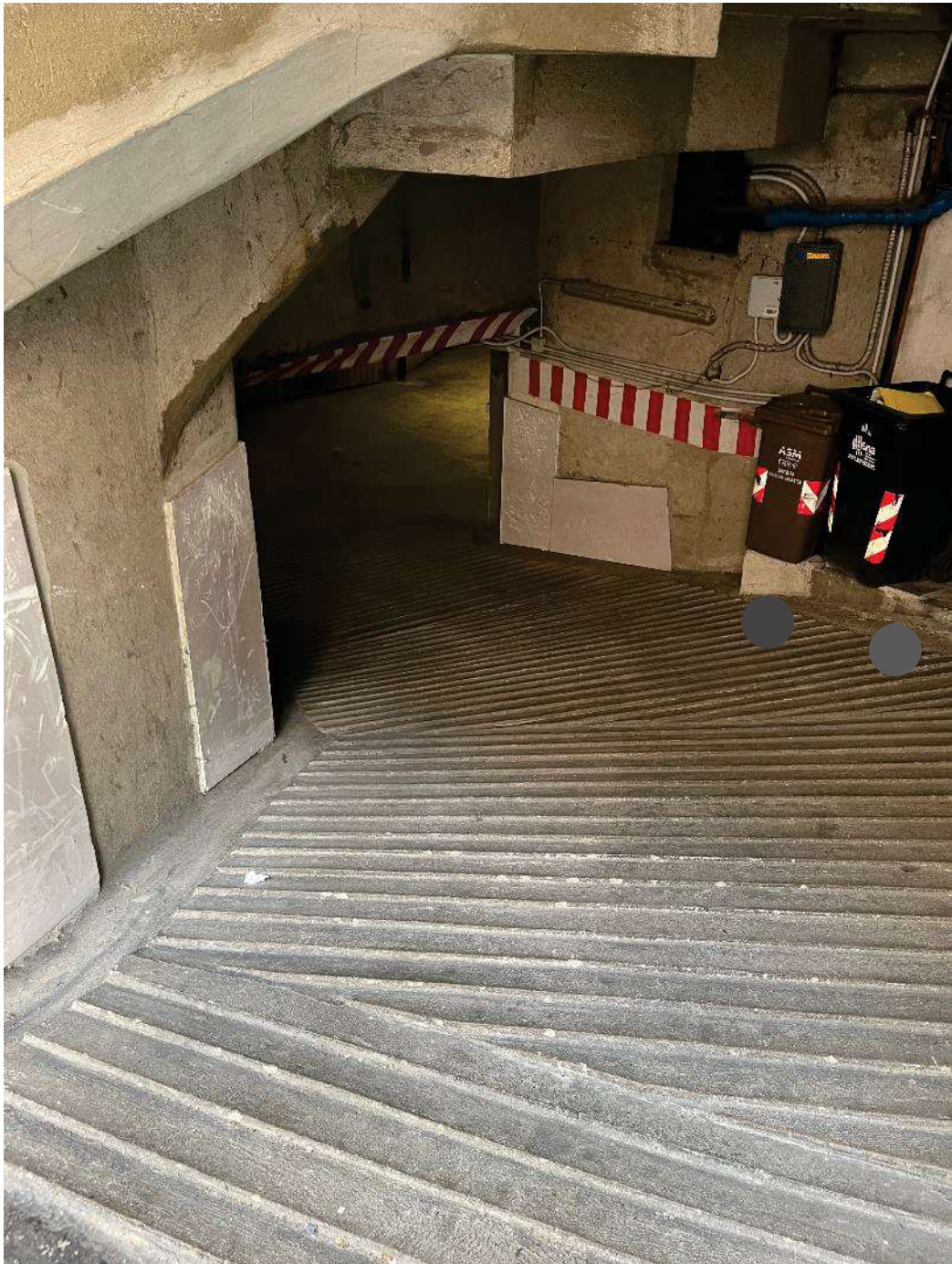
Figura 39: vista rampa ingresso rimesse
