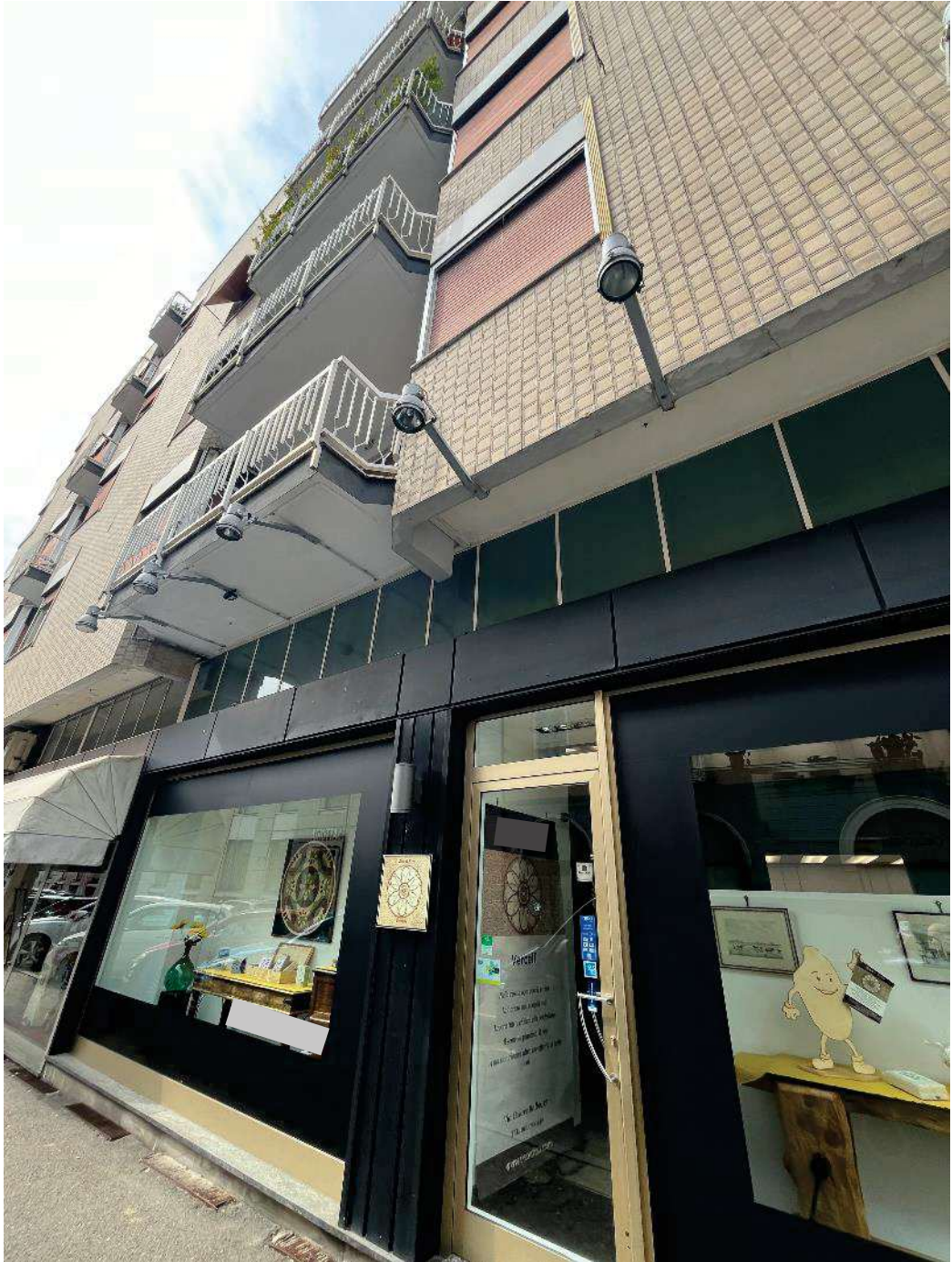
Figura 6: vista d'insieme del bene e suo inserimento nel fabbricato sulla via Cesare Balbo
