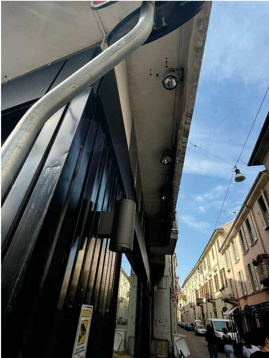
Figura 8: dettaglio illuminazione via Fratelli Laviny
