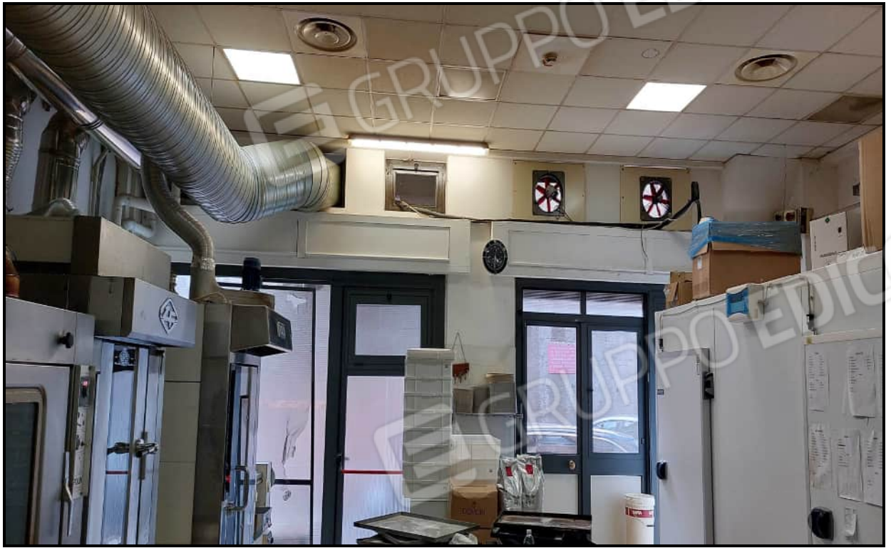
Foto 3. Vista dall'interno del locale dei due infissi
