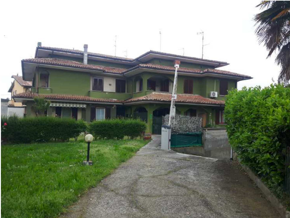
Fotografia n. 2 – Vista lato Via Massimiliano Kolbe – Dettaglio
