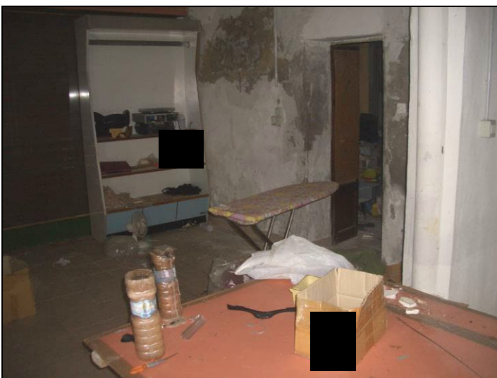
Vista interna P.T. porzione fabbricato civ. 57
