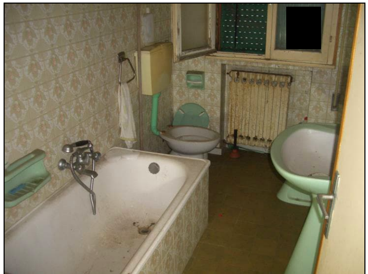
Vista interna P.1° porzione fabbricato civ. 55
