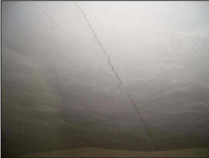
Vista interna P.1° porzione fabbricato civ. 55
