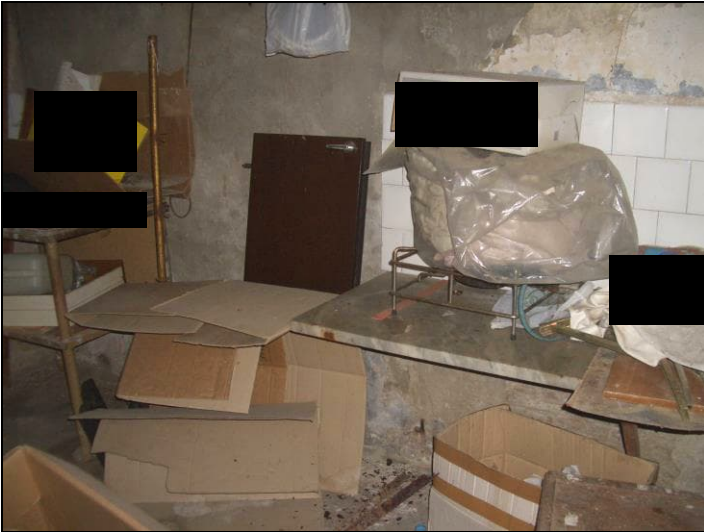
Vista interna P.T. porzione fabbricato civ. 57
