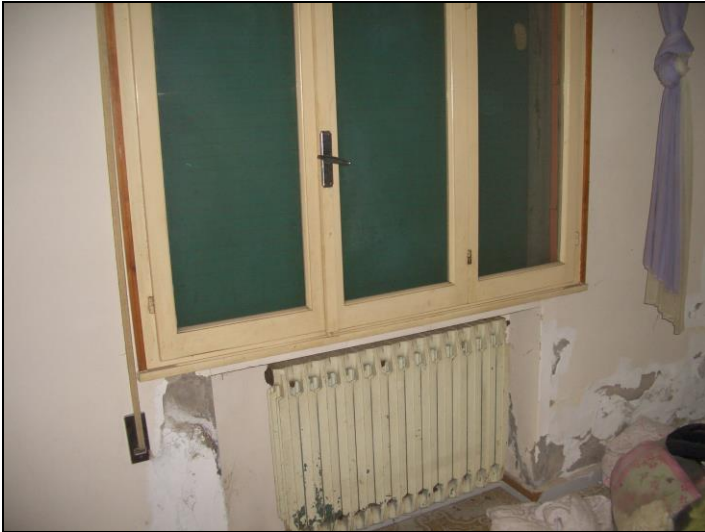
Vista interna P.T. porzione fabbricato civ. 55
