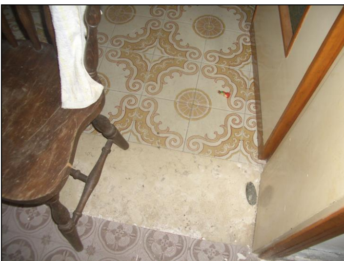
Vista interna P.T. porzione fabbricato civ. 55
