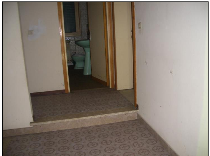
Vista interna P.1° porzione fabbricato civ. 55
