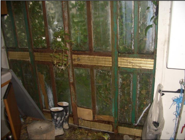
Vista interna P.T. porzione fabbricato civ. 55
