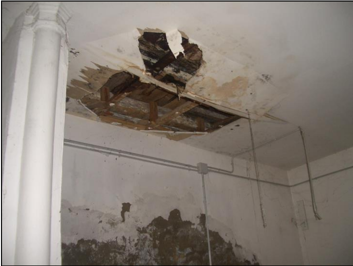
Vista interna P.T. porzione fabbricato civ. 57
