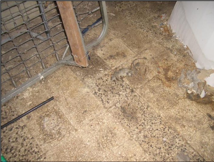
Vista interna P.T. porzione fabbricato civ. 57
