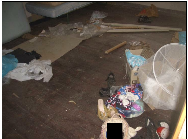
Vista interna P.1° porzione fabbricato civ. 55
