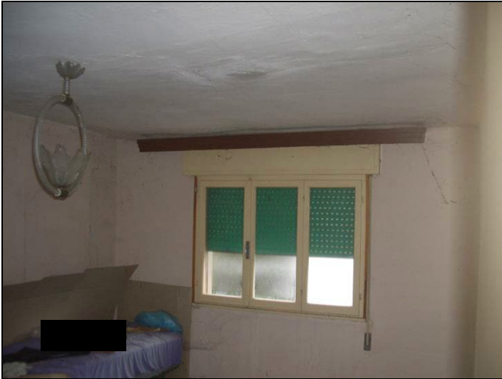
Vista interna P.1° porzione fabbricato civ. 55
