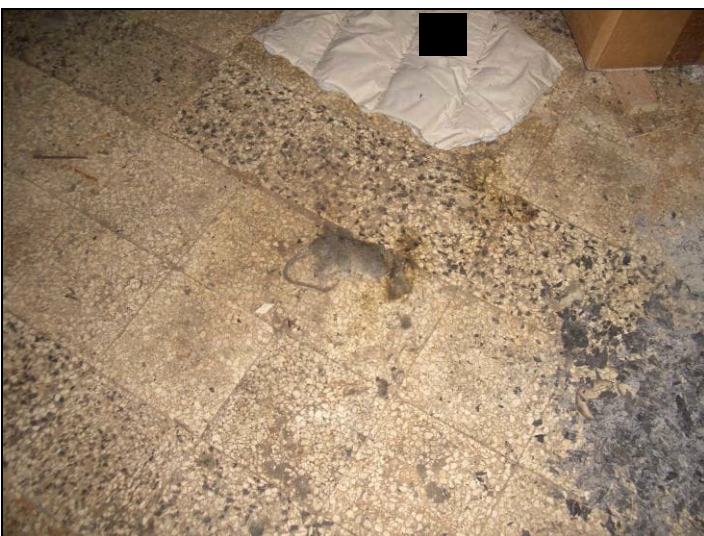
Vista interna P.T. porzione fabbricato civ. 57
