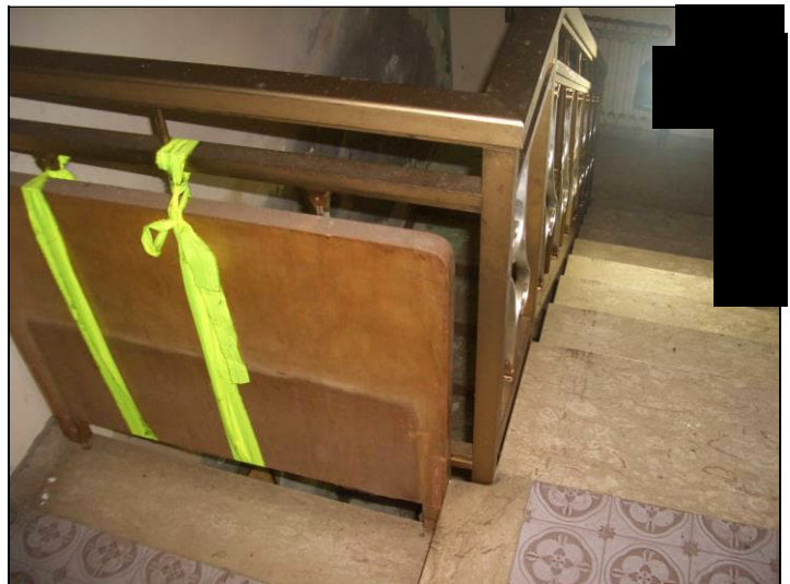
Vista interna P.1° porzione fabbricato civ. 55
