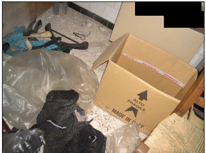
Vista interna P.T. porzione fabbricato civ. 57
