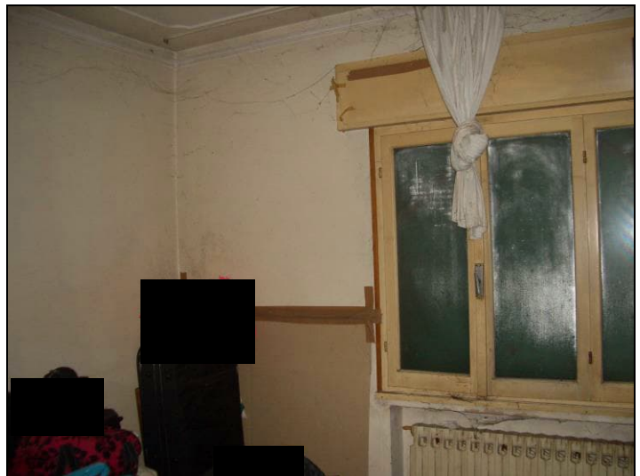
Vista interna P.T. porzione fabbricato civ. 55
