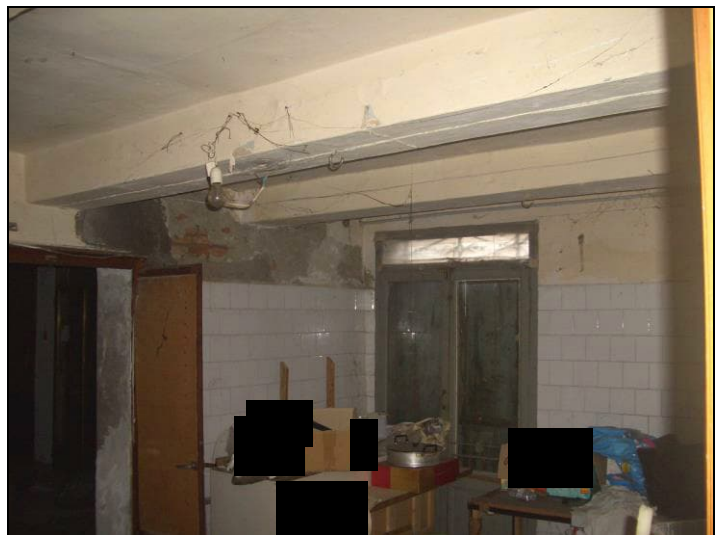
Vista interna P.T. porzione fabbricato civ. 55
