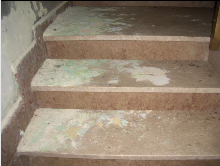
Vista interna P.T. porzione fabbricato civ. 55
