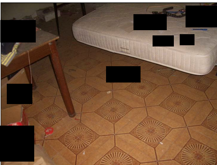
Vista interna P.1° porzione fabbricato civ. 55
