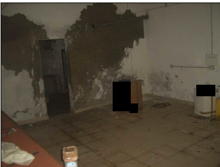
Vista interna P.T. porzione fabbricato civ. 57
