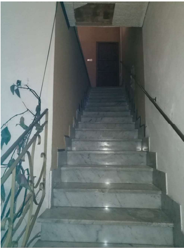
Foto 10 – Vano scala, portone di ingresso al P.1°
