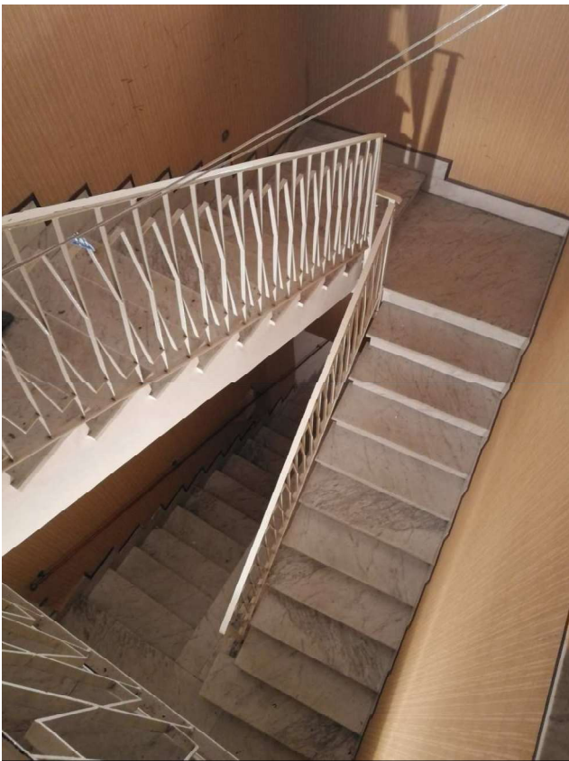
Foto 14 – Vano scala (vista dall'alto)
