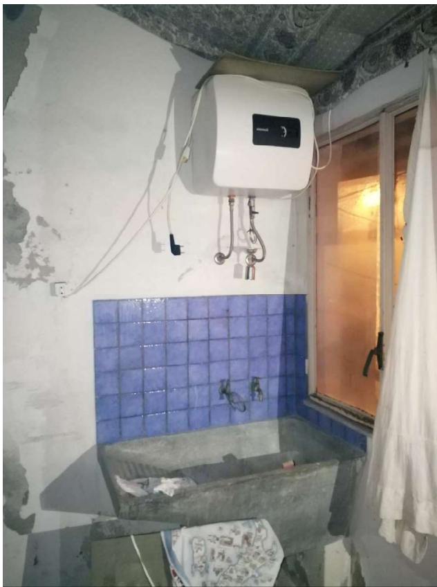
Foto 38 – P.2° Locale di sgombero
