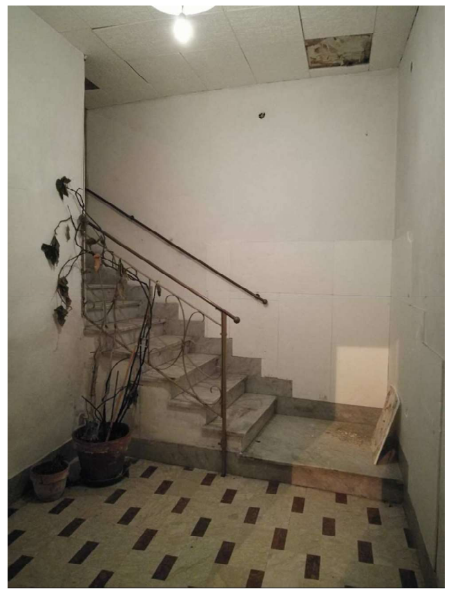
Foto 9 – Locale di ingresso a P.T.
