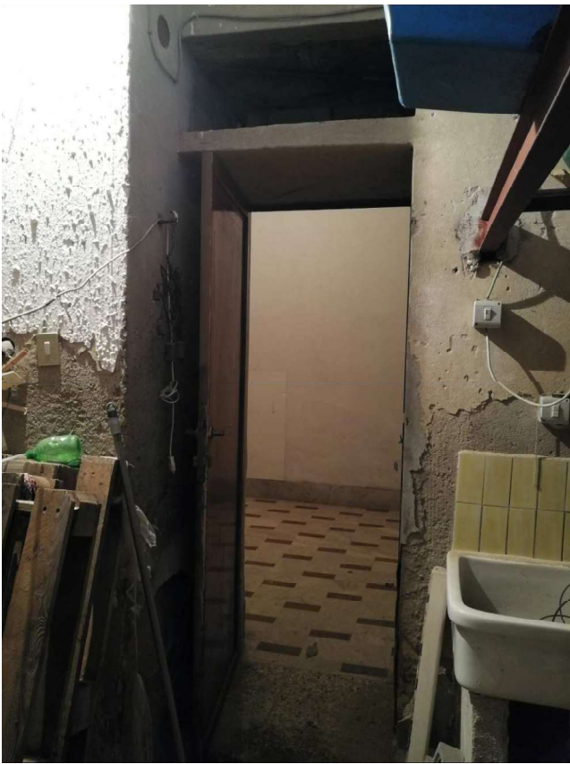
Foto 6 – Locale di sgombero a P.T.
