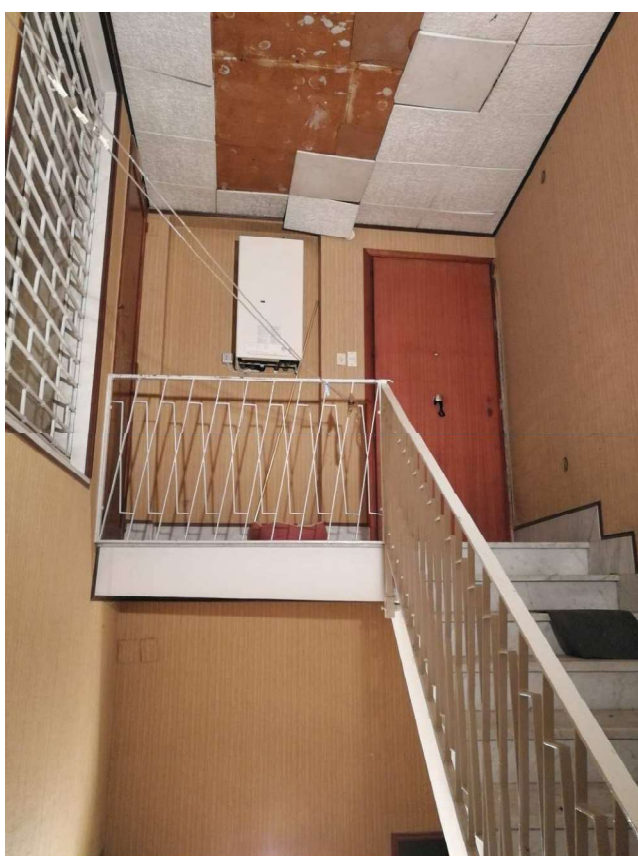
Foto 12 – Vano scala, portone di ingresso al P.2° (sottotetto)
