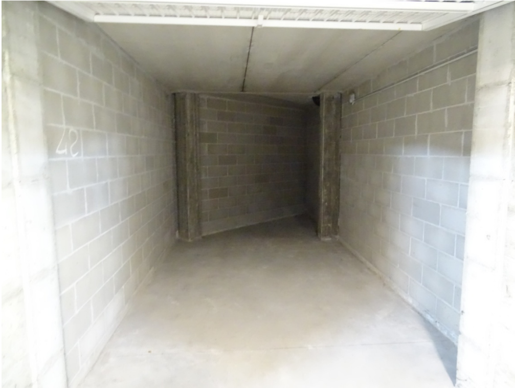
Vista box interno Lotto 2
