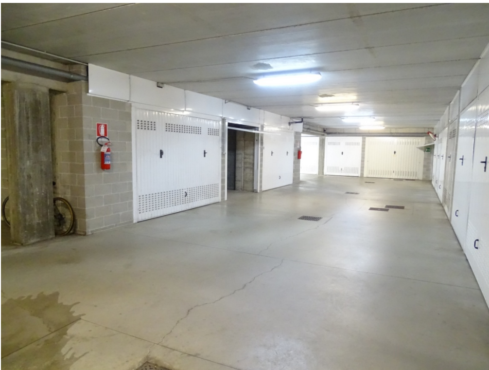
Vista ingresso box dal corsello Lotto 2
