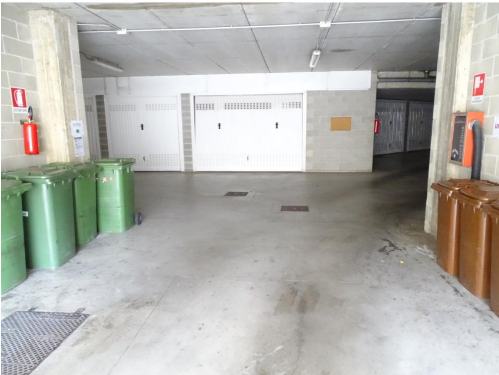
Vista corsello box
