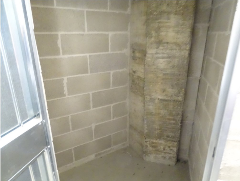
Vista interna cantina Lotto 1
