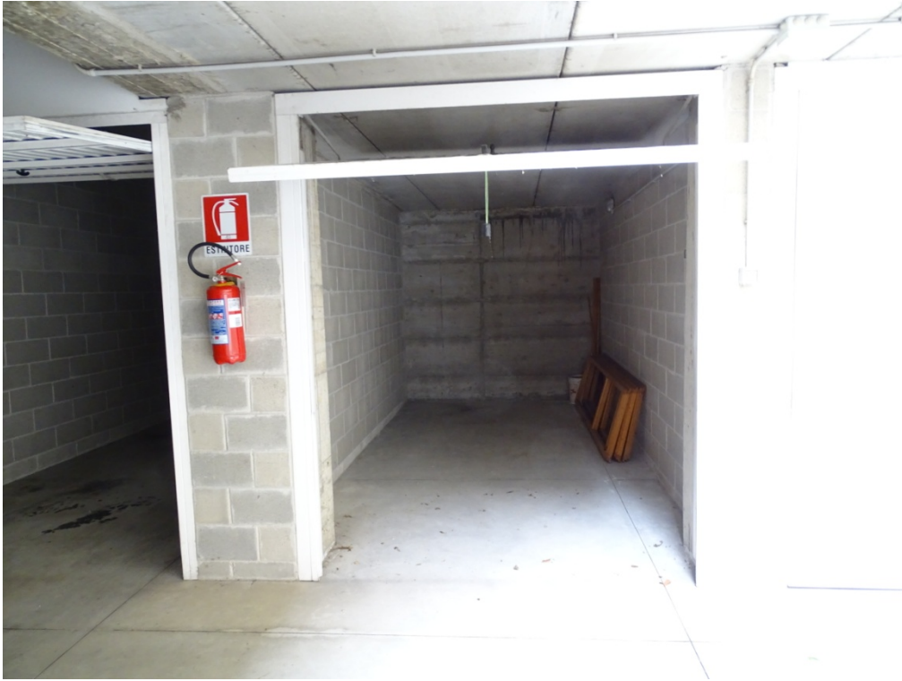
Vista box interno Lotto 1
