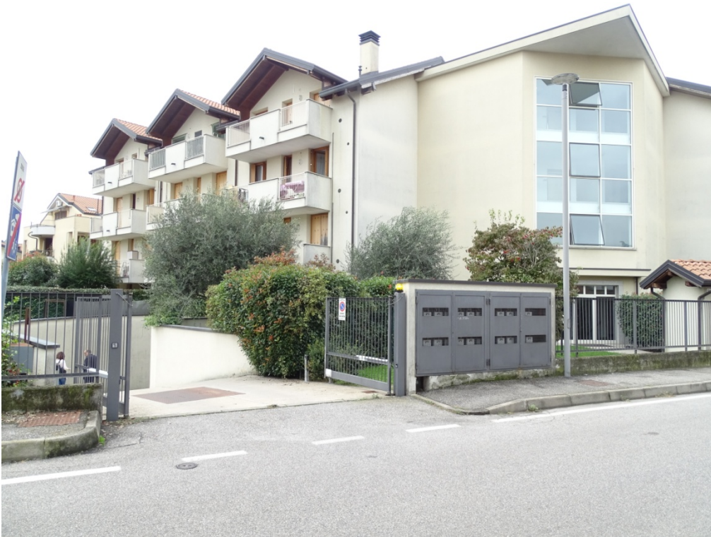
Vista passo Carraio da via Montecchio
