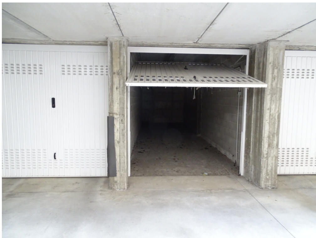
Vista ingresso box dal corsello Lotto 4
