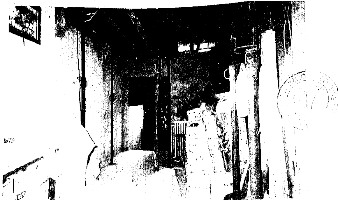
FOTO 1 RILIEVO FOTOGRAFICO ESEGUITO DALL'ISER DI VIG. GORIN DOMENICO IN LOCALITA' VENEZIA LIDO VIA M. BRAGADIN N. 30 IL 18.01.2002 RITRAFFENTE LA NUOVA PARETE IN MURATURA CON IL FORO PORTA POSTO IN CORRISPONDENZA DELLA SCALA DI ACCESSO AL TERRAZZO SITO AL PIANO AMMEZZATO.
