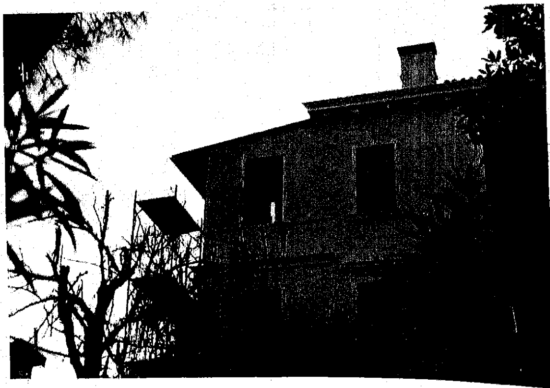
FOTO 16 RILIEVO FOTOGRAFICO ESEGUITO DALL'ISTR. DI VIG. GORIN DOMENICO IN LOCALITA' VENEZIA LIDO DELL'HOTEL BYRON CENTRALE IN VIA M. BRAGADIN N. 30 II. 02.04.2002 RETRAENTE IL NUOVO FORO FINESTRA CON SERRAMENTO E LA PARTE DI VECCHIO ABUSO INTONACATO E DIPINTO GIÀ SEGNALATO NELL'INTEGRAZIONE DEL 09.02.2002 SU VIA M. BRAGADIN (ZONA GIALLA LELESTE ) INDAGATI: [REDACTED]
