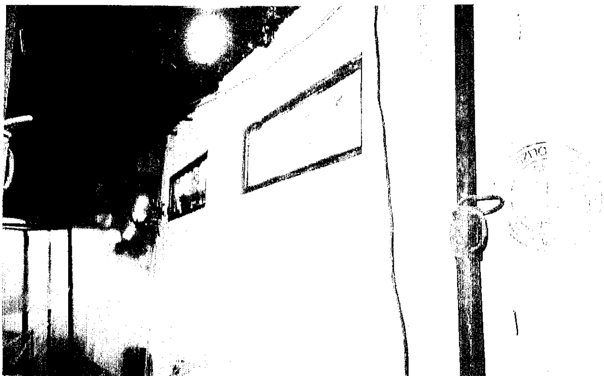
FOTO 2 RILIEVO FOTOGRAFICO ESEGUITO DALL'ISER DI VIG. GORIN DOMENICO IN LOCALITA' VENEZIA LIDO VIA M. BRAGADIN N. 30 IL 18.01.2002 RITRAFFENTE LA NUOVA PARETE IN MURATURA SORTA SUL MURETTO DI CONGINE CON ALTRA PROPRIETA' ED I DUE FINESTRINI SUL TERRAZZO SITO AL PIANO AMMEZZATO.
