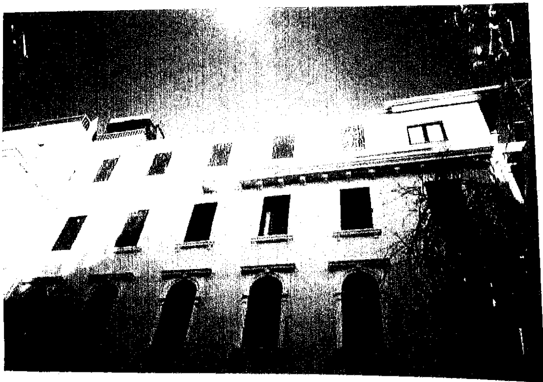
FOTO 14 RILIEVO FOTOGRAFICO ESEGUITO DALL'ISTR. DI VIG. GORIN DOMENICO IN LOCALITA' VENEZIA LIDO DELL'HOTEL BYRON CENTRALE IN VIA M. BRAGADIN N. 30 IL DARDANELLO (ZONA CELESTE). INDAGATE
