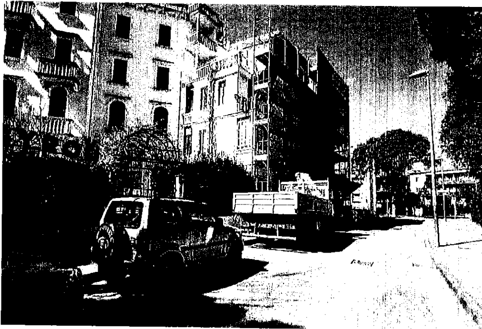
Fronte est - Marzo 2019 durante i lavori di ripristino dello stato legittimato
