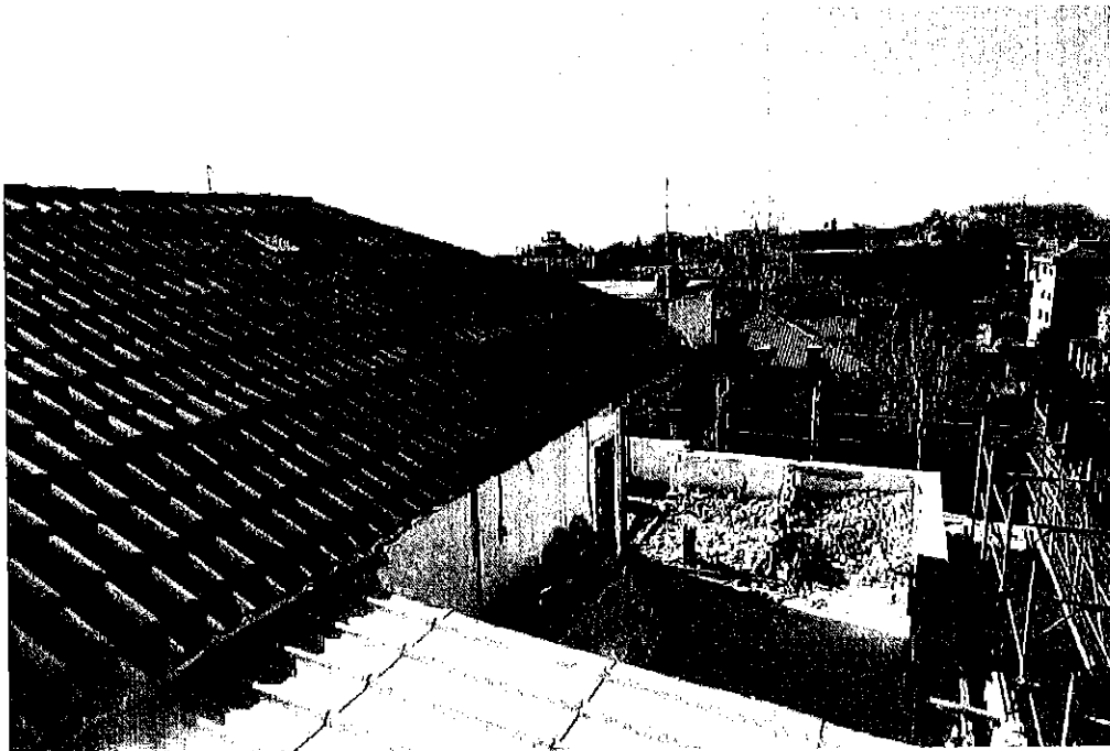
Fronte sud ovest - Marzo 2019 durante i lavori di ripristino dello stato legittimato.
