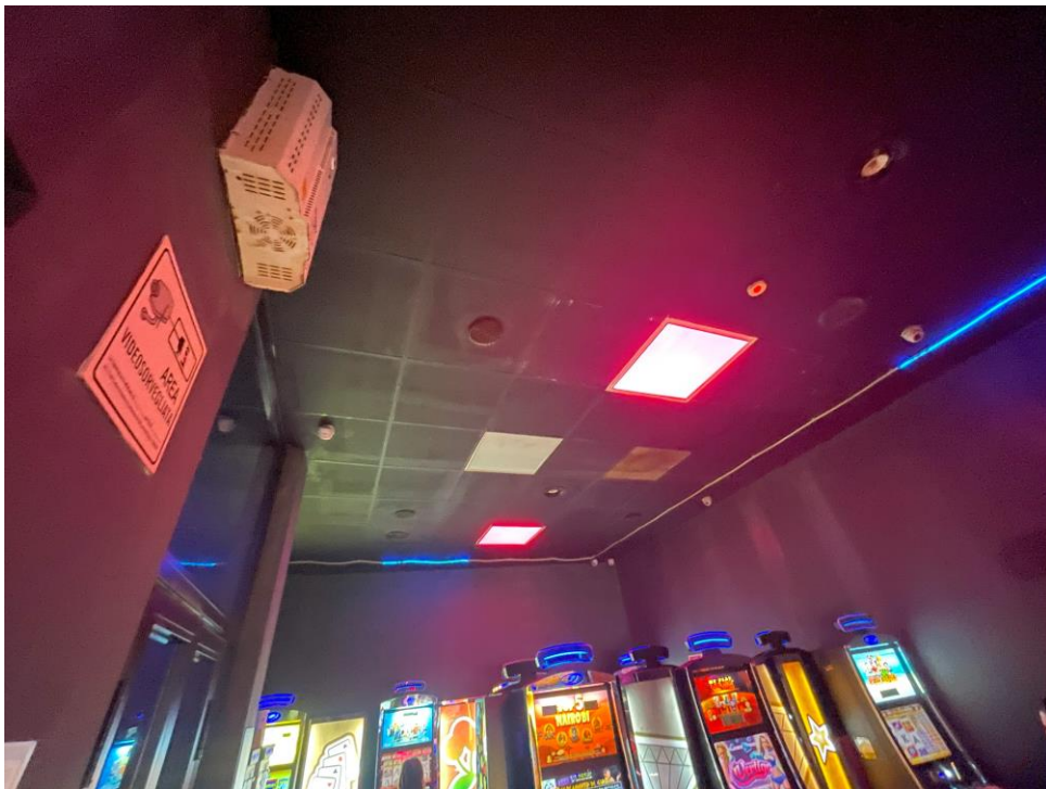
Foto 10 – Vista interni particolare controsoffitto
