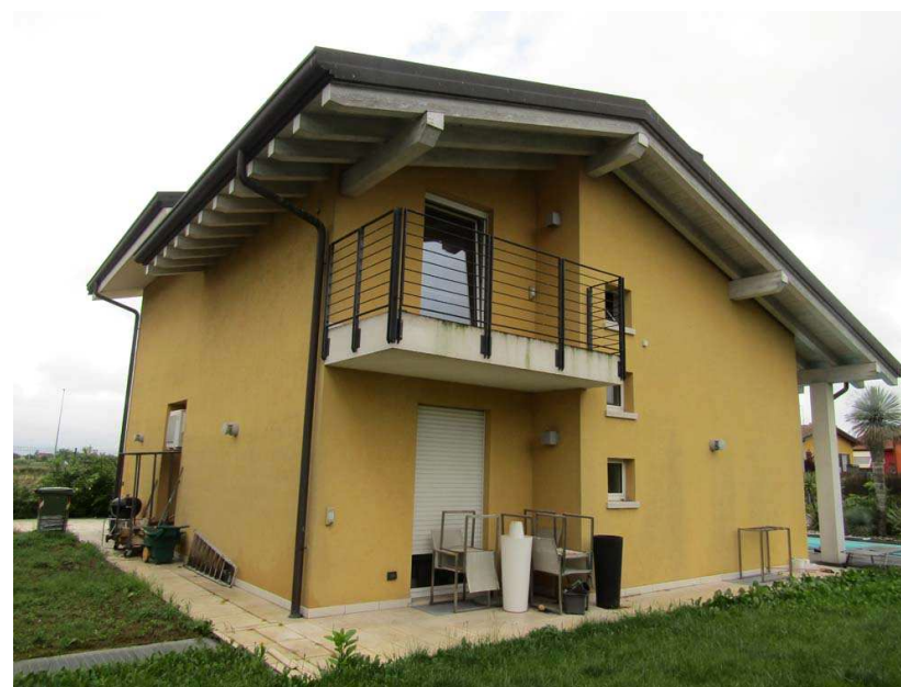
Foto 6: scorcio sui prospetti nord ed est
