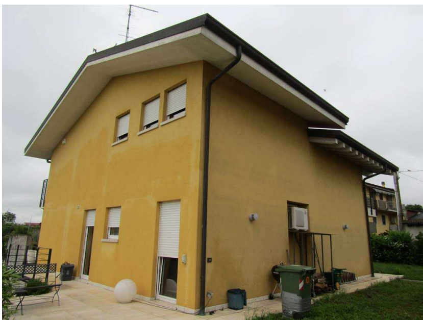
Foto 7: vista d'insieme dei prospetti est e sud
