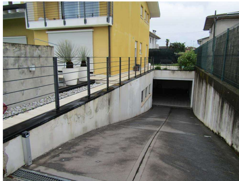
Foto 10: vista della rampa carraia di accesso all'autorimessa a sud
