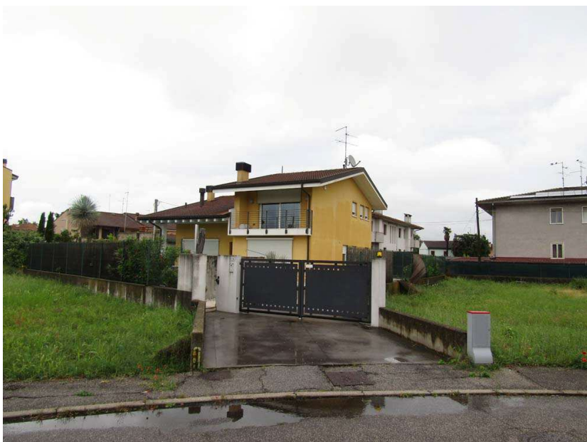
Foto 1: vista d'insieme dell'edificio da via Personi a sud-ovest
