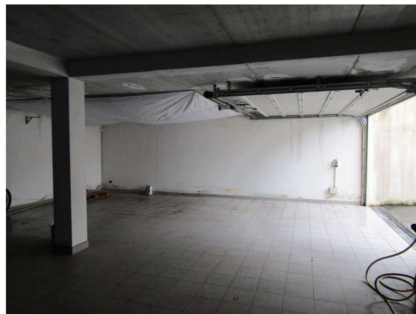
Foto 32: altra vista dell'autorimessa
