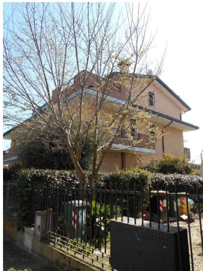
Foto 3: porzione in oggetto, facciata ovest
