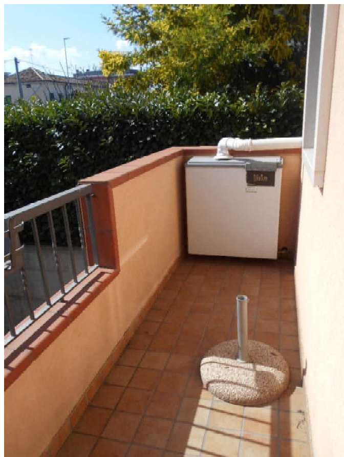
Foto 21: terrazzino della cucina
