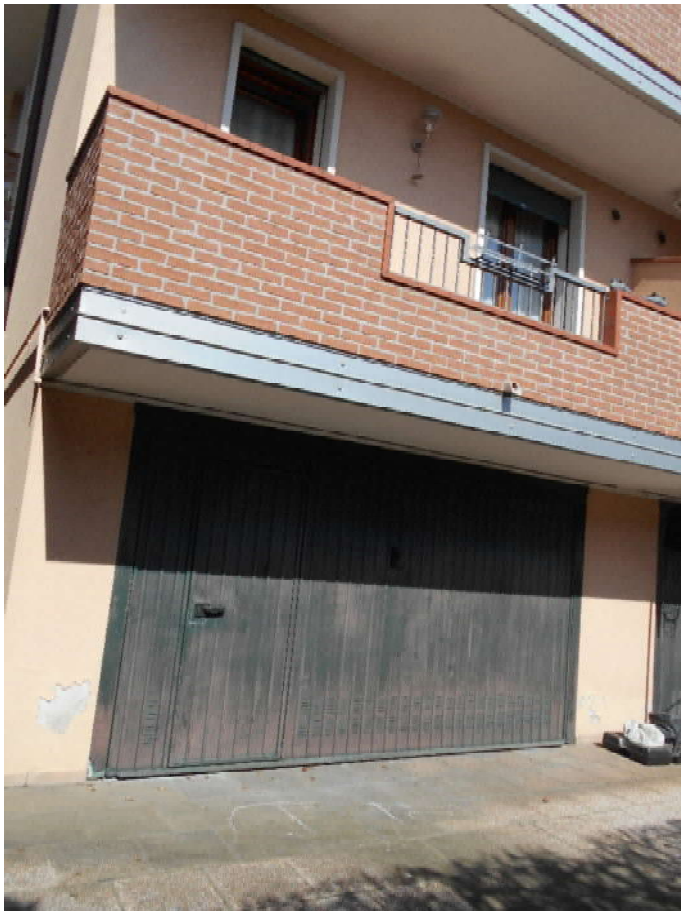
Foto 10: portone garage in oggetto
