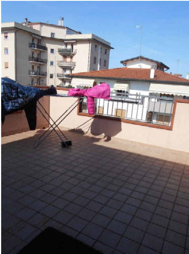
Foto 33: terrazza piano sotto-tetto, lato nord
