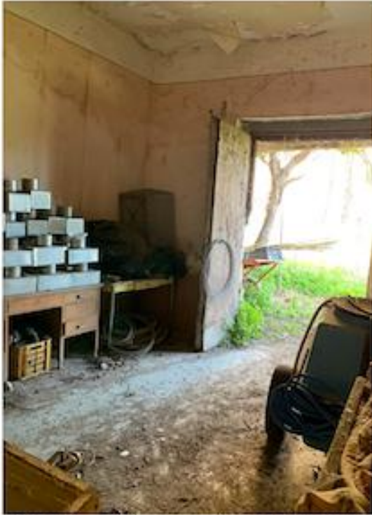
Foto n.4 – particolare ingresso in vano utile
