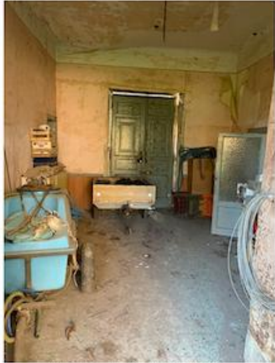
Foto n.5 – particolare vano utile
