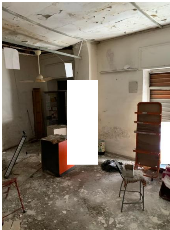
Foto n.5 – particolare locale commerciale
