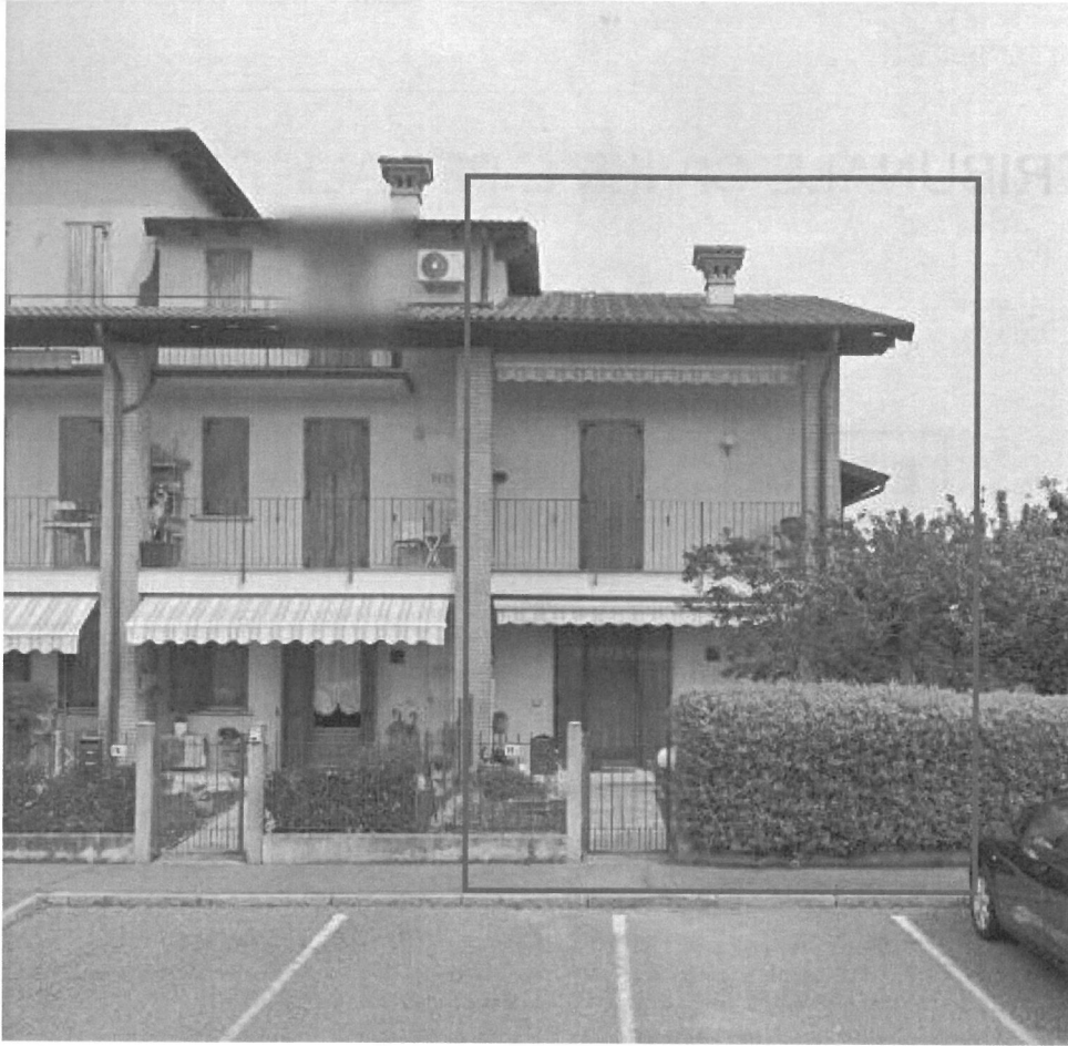
Fabbricato - Lato ovest
