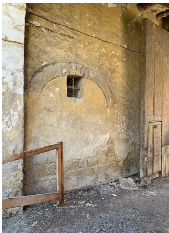
Foto n.5 – particolare tompagno di confine
