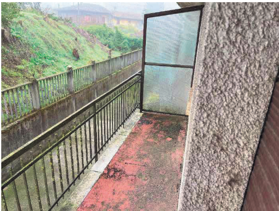
FOTO 14 – BALCONE LATO CORTILE INTERNO
