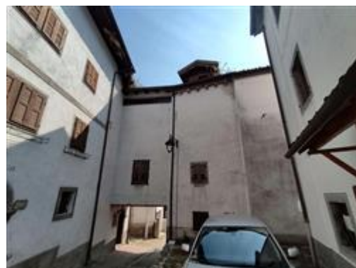
Vista retro lato Ovest
