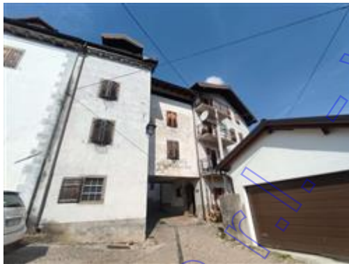
Vista fronte Est
