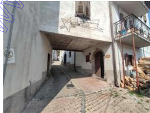
Portico con ingressi lato Est
