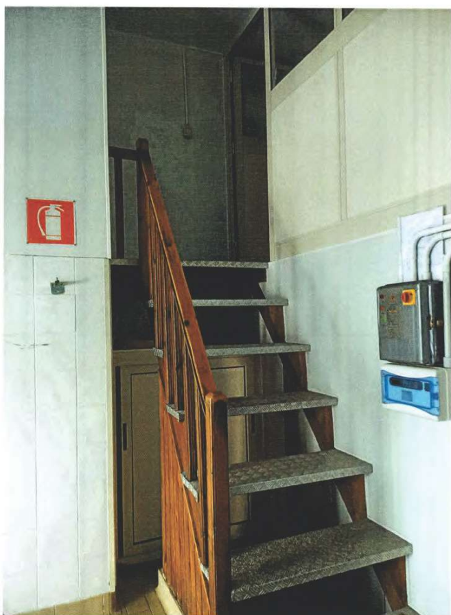
SCALA INGRESSO SOPPALCO NEL SUB. 1
