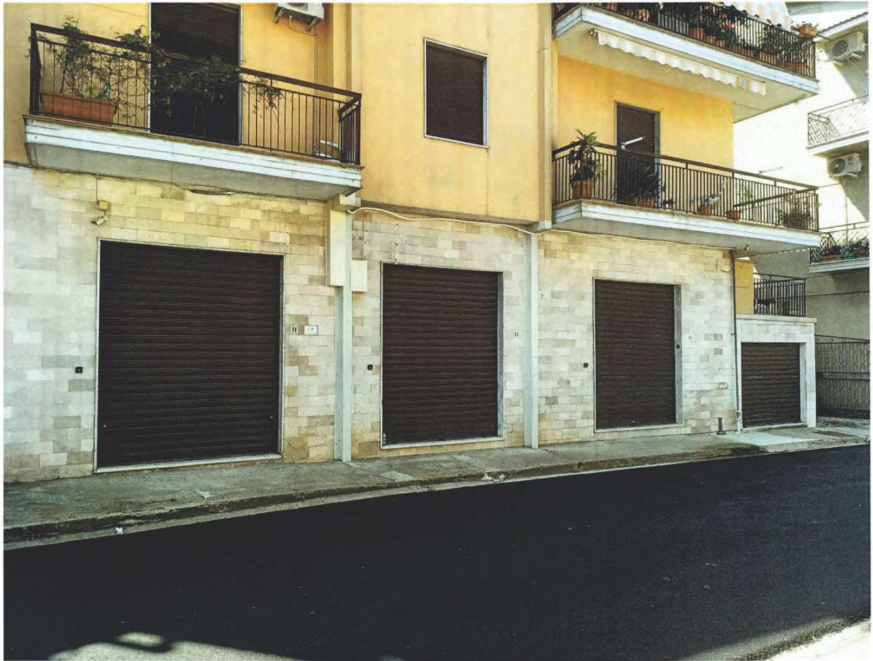
VISTA ESTERNA DI TUTTI I SUB. SU VIA GRAMSCI
