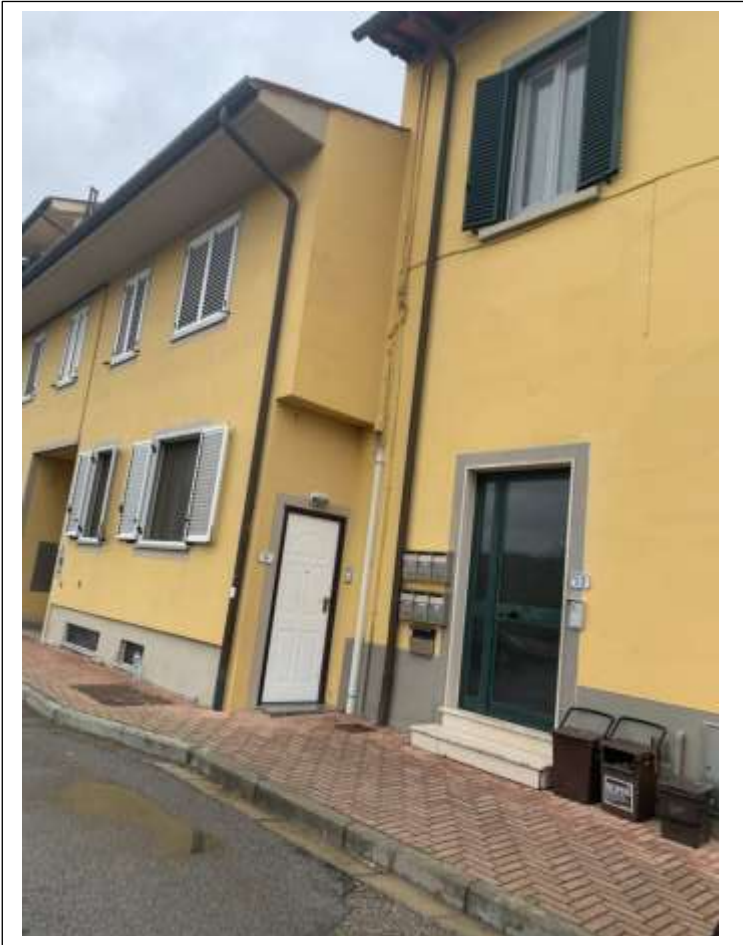
VISTA DA ESTERNO FABBRICATO
