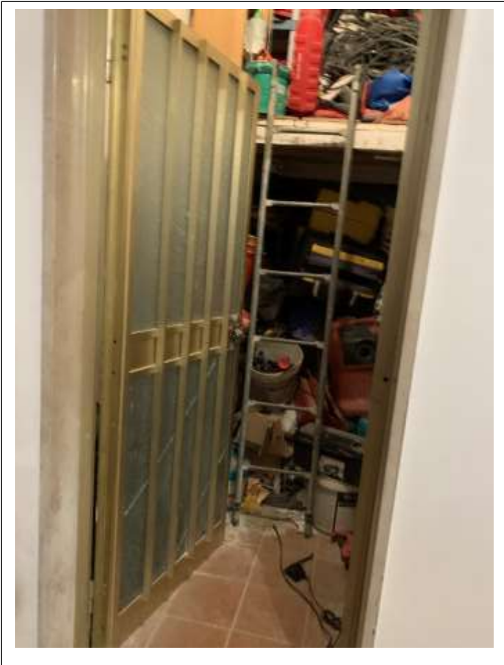
RIPOSTIGLIO AL PIANO TERRA
