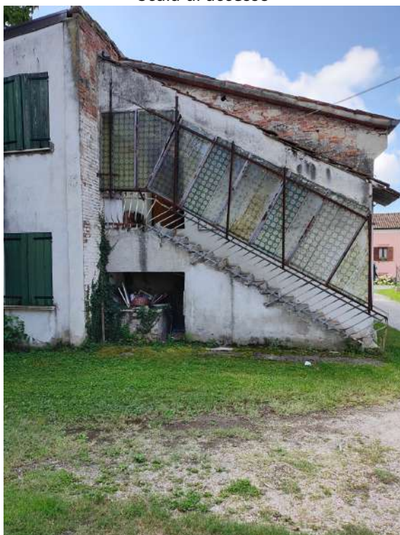
Scala di accesso
