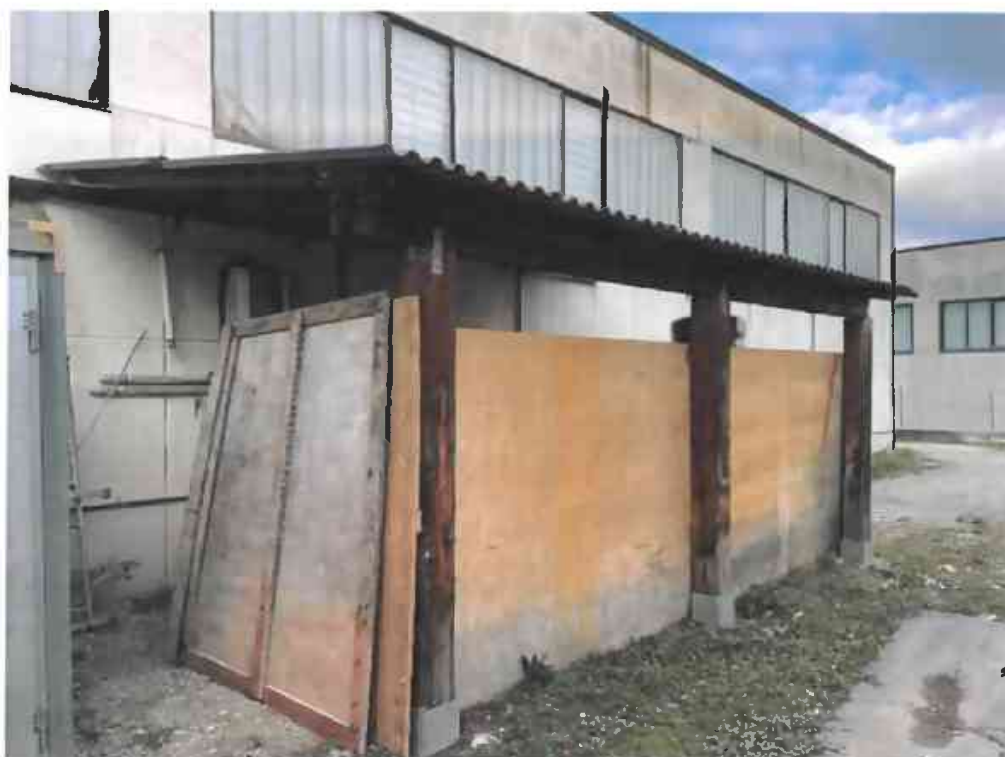
Foto 08 – Tettoia sul retro da smontare
