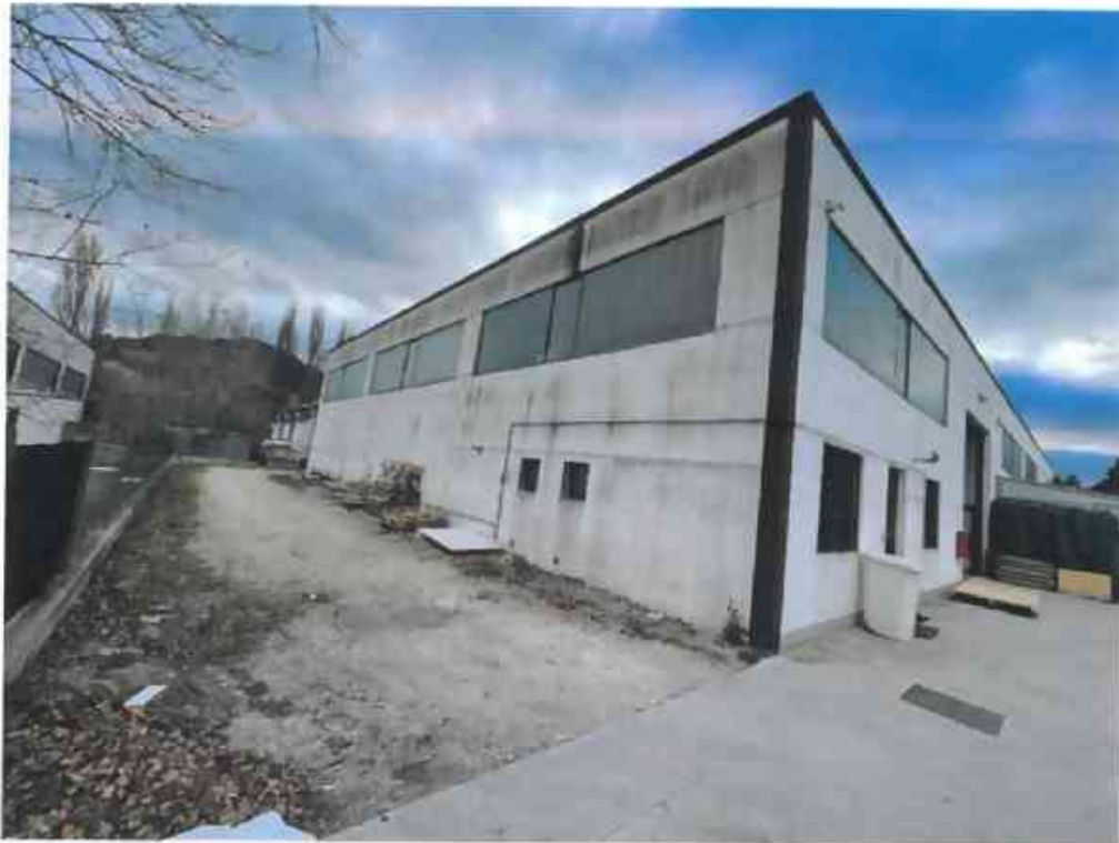
Foto 04 – Prospetto fianco sinistro
