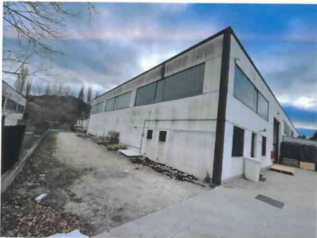
Foto 04 – Prospetto fianco sinistro
