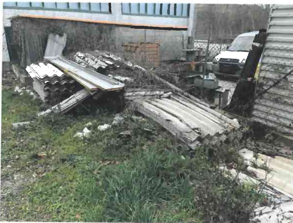
Foto 09 – Materiali da smaltire posti sull'area comune
