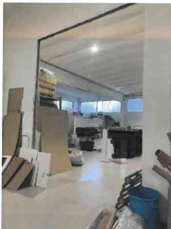
Foto 12 – Apertura tra le unità da ripristinare
