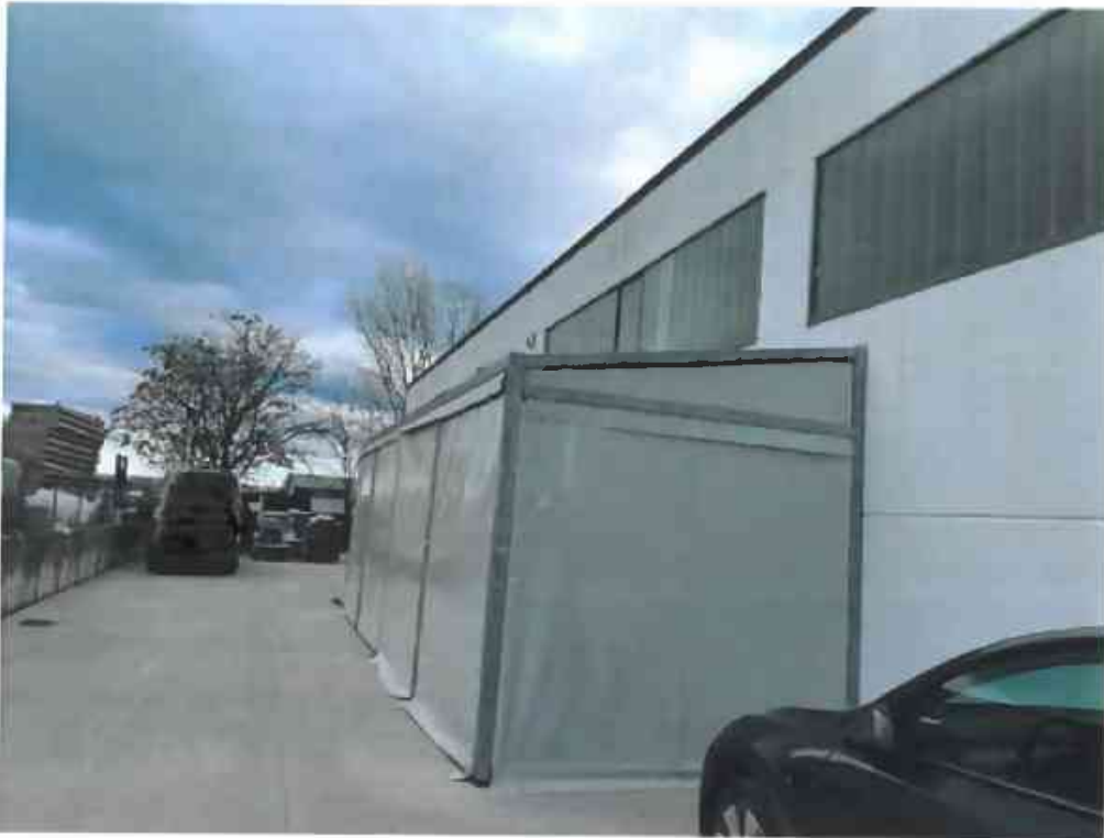
Foto 03 – Prospetto fronte con individuazione manufatto da smontare
