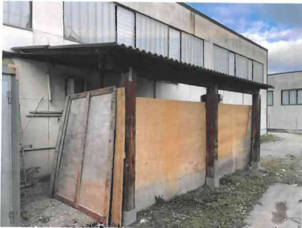
Foto 08 – Tettoia sul retro da smontare
