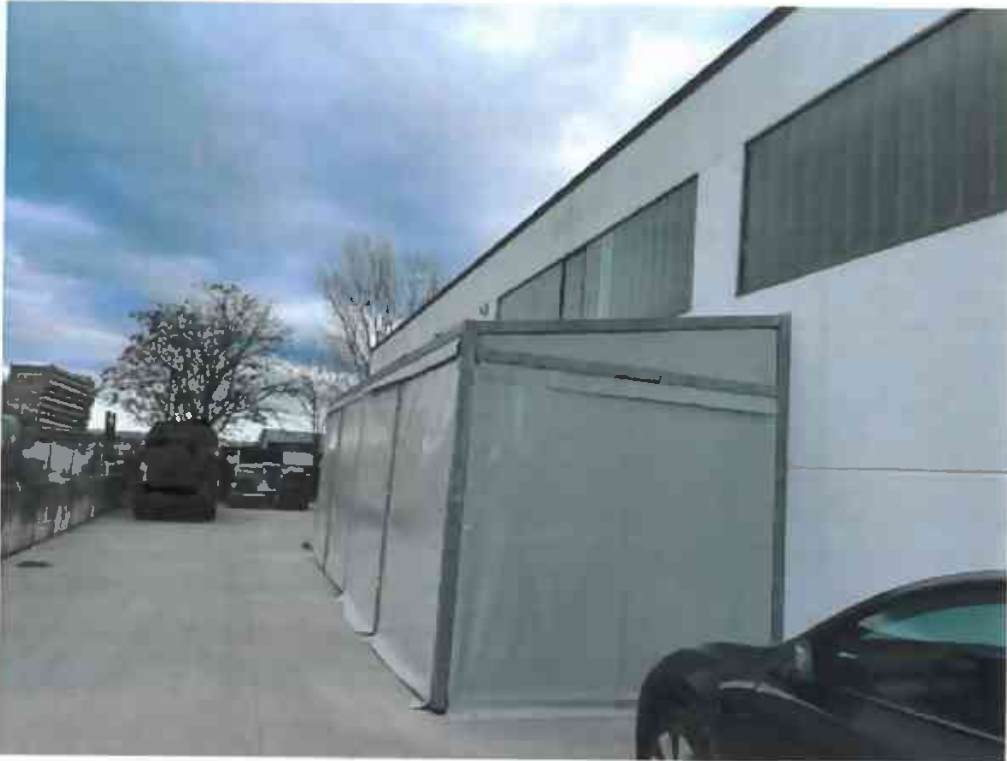
Foto 03 – Prospetto fronte con individuazione manufatto da smontare
