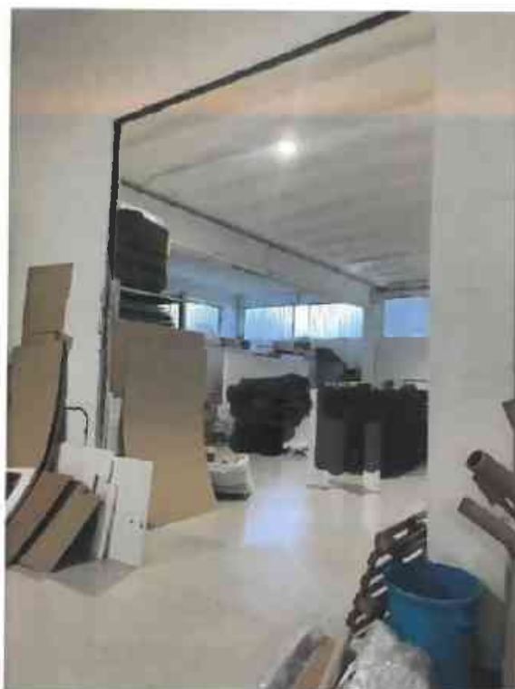
Foto 13 – Apertura tra le unità da ripristinare
