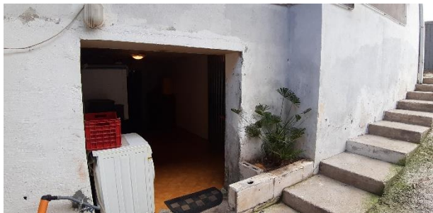
Vista Esterna E4
