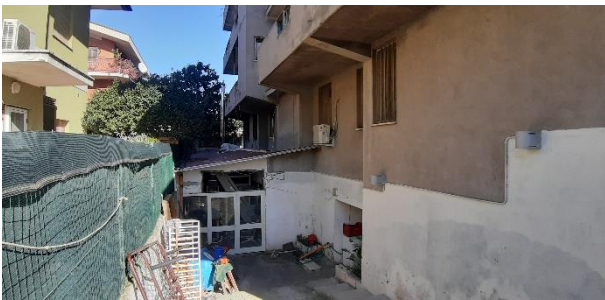
Vista Esterna E3
