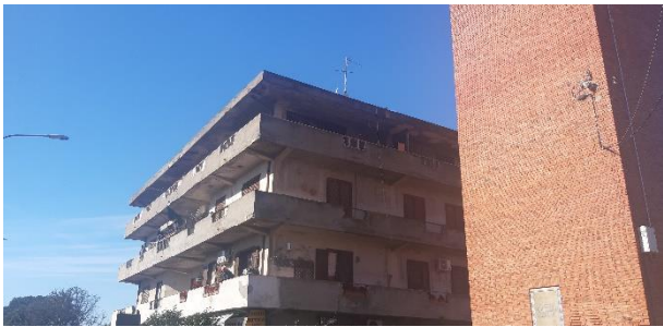
Vista Esterna E1
