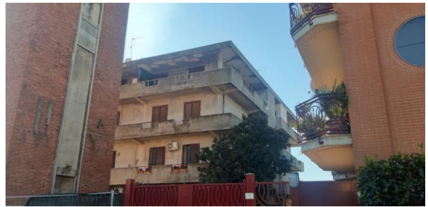
Vista Esterna E2
