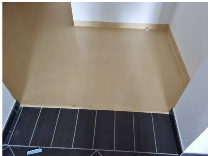
Foto 39 – Particolare pavimentazioni LOTTO 6
