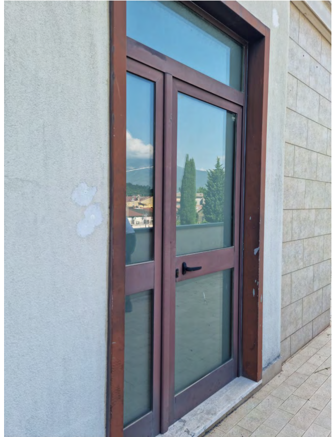
Foto 37 – Particolare porta esterna d'ingresso LOTTO 6
