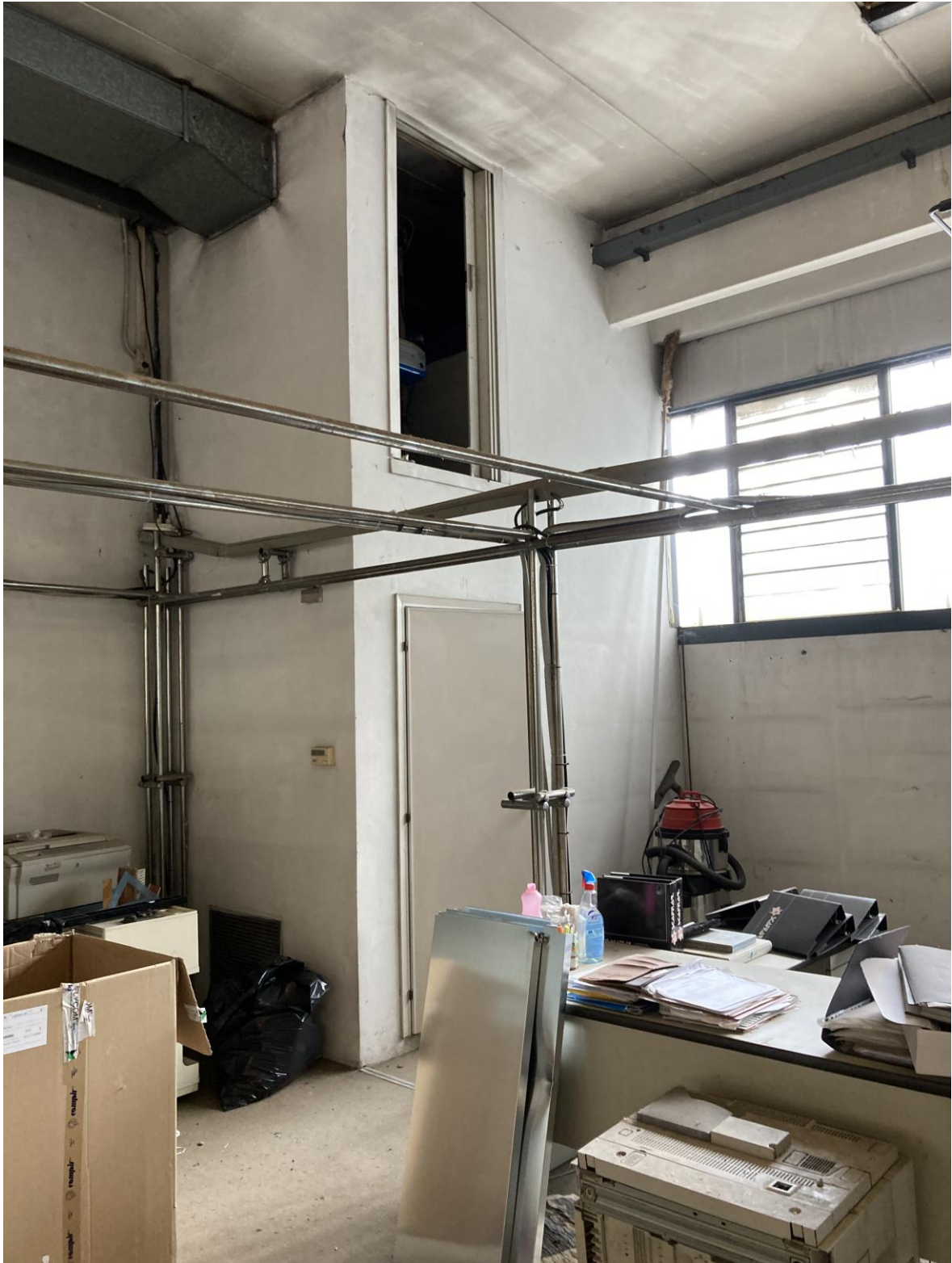
FOTO 3 –INTERNO DEL LOCALE AL P1 (LOTTO B). Ingresso al bagno e locale tecnico sopra
