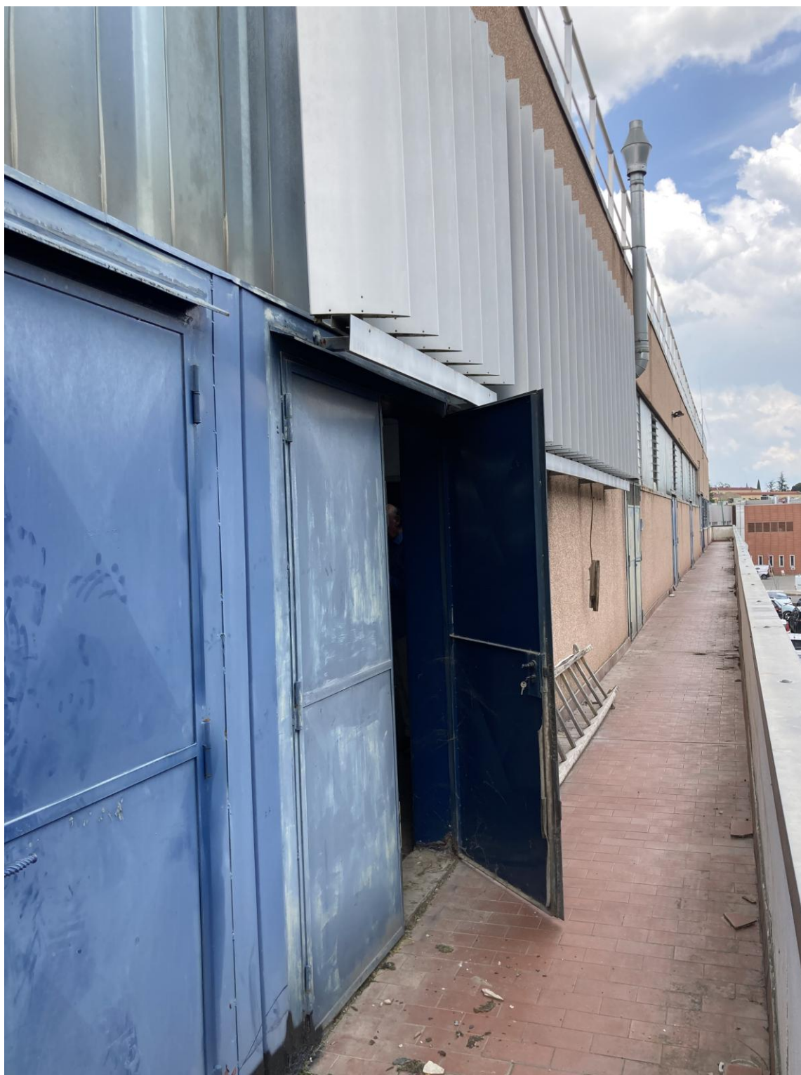
FOTO 5 – USCITA DI SICUREZZA (LOTTO B).
