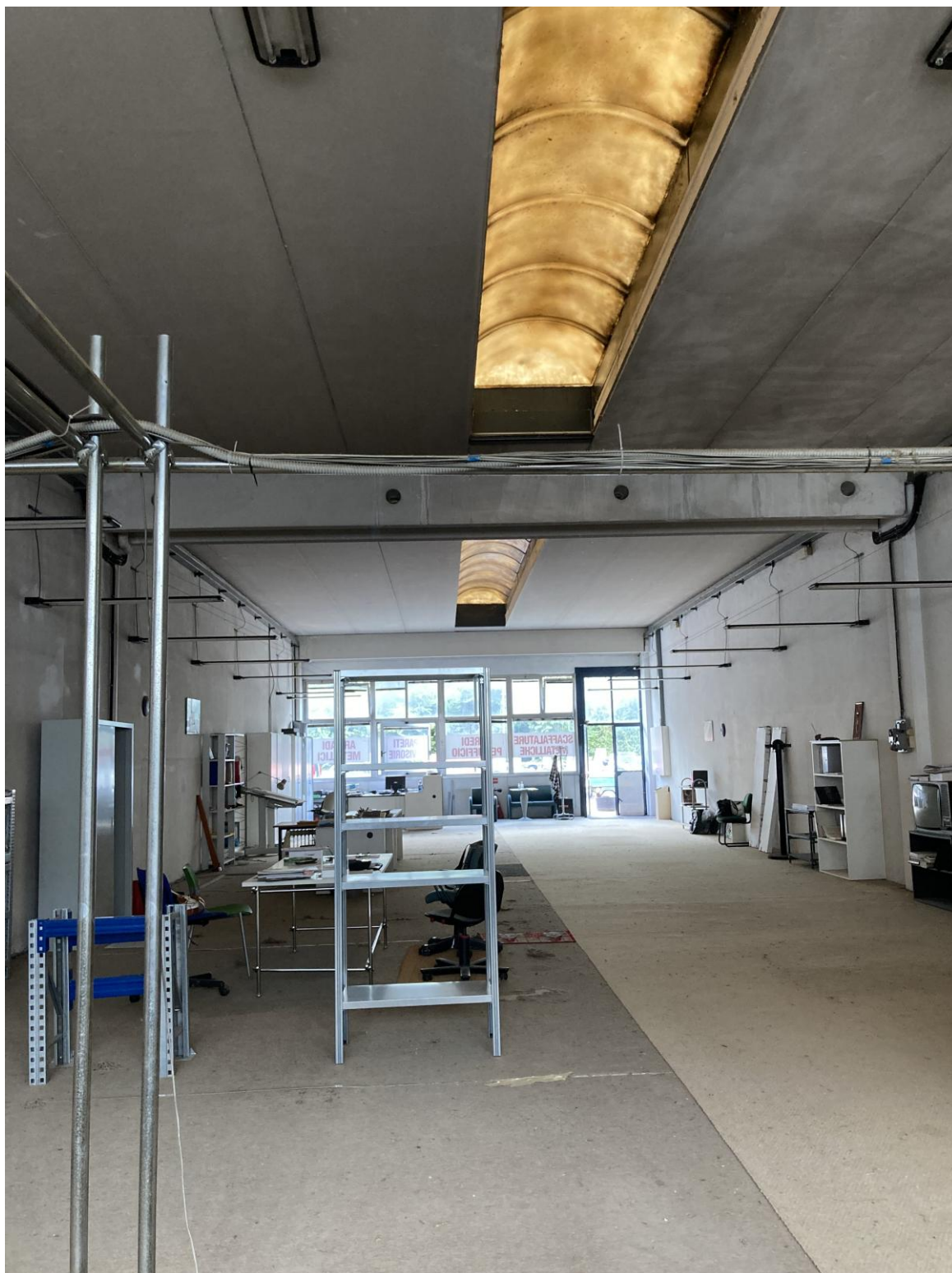
FOTO 1 –INTERNO DEL LOCALE AL P1 (LOTTO B)
