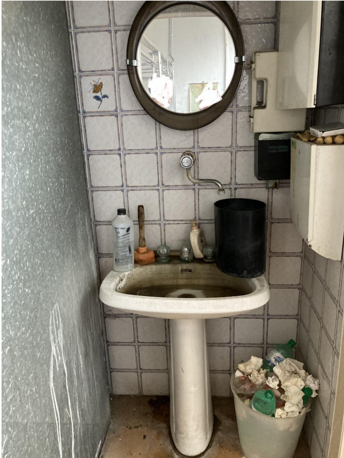
FOTO 4 –INTERNO DEL LOCALE AL P1 (LOTTO B). Antibagno
