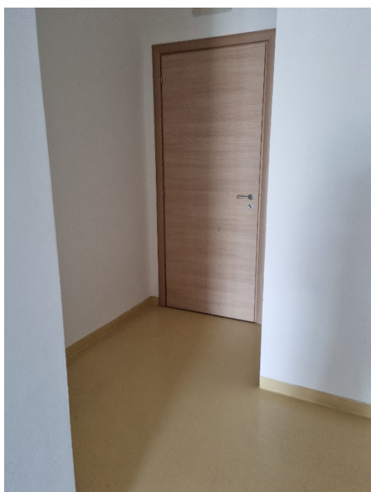
Ingresso LOTTO 6 da vano scala condominiale posteriore
