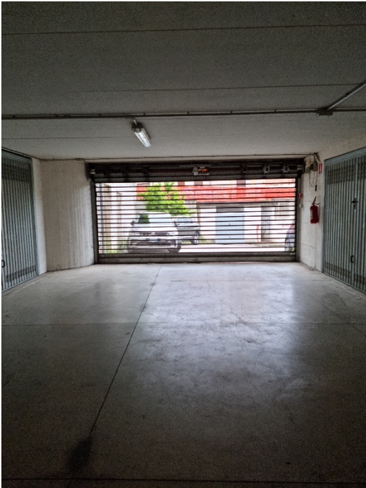
Corsia di manovra garage PSI LOTTO 7
