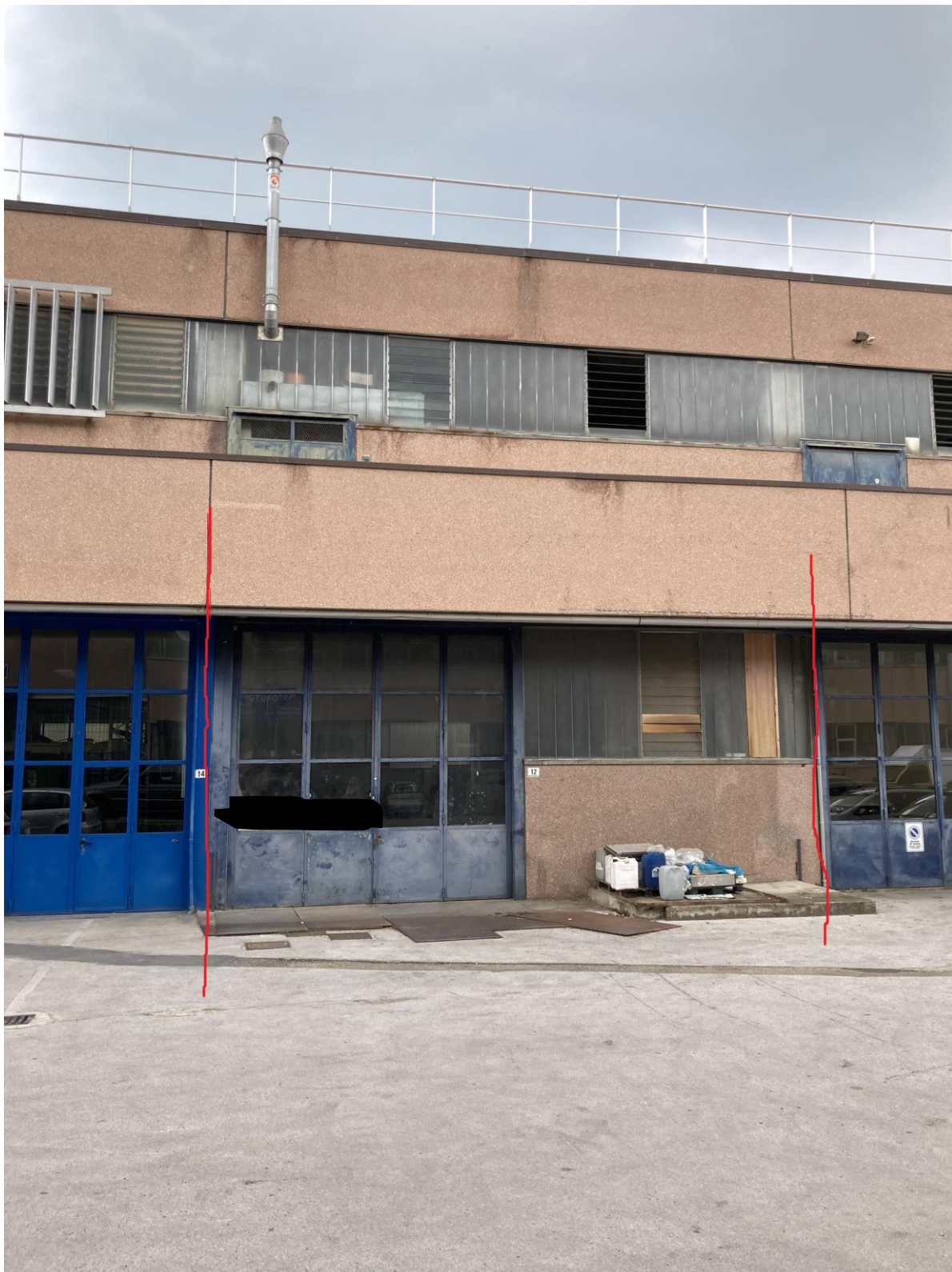
FOTO 8 –INGRESSO PIANO TERRA (LOTTO A).
