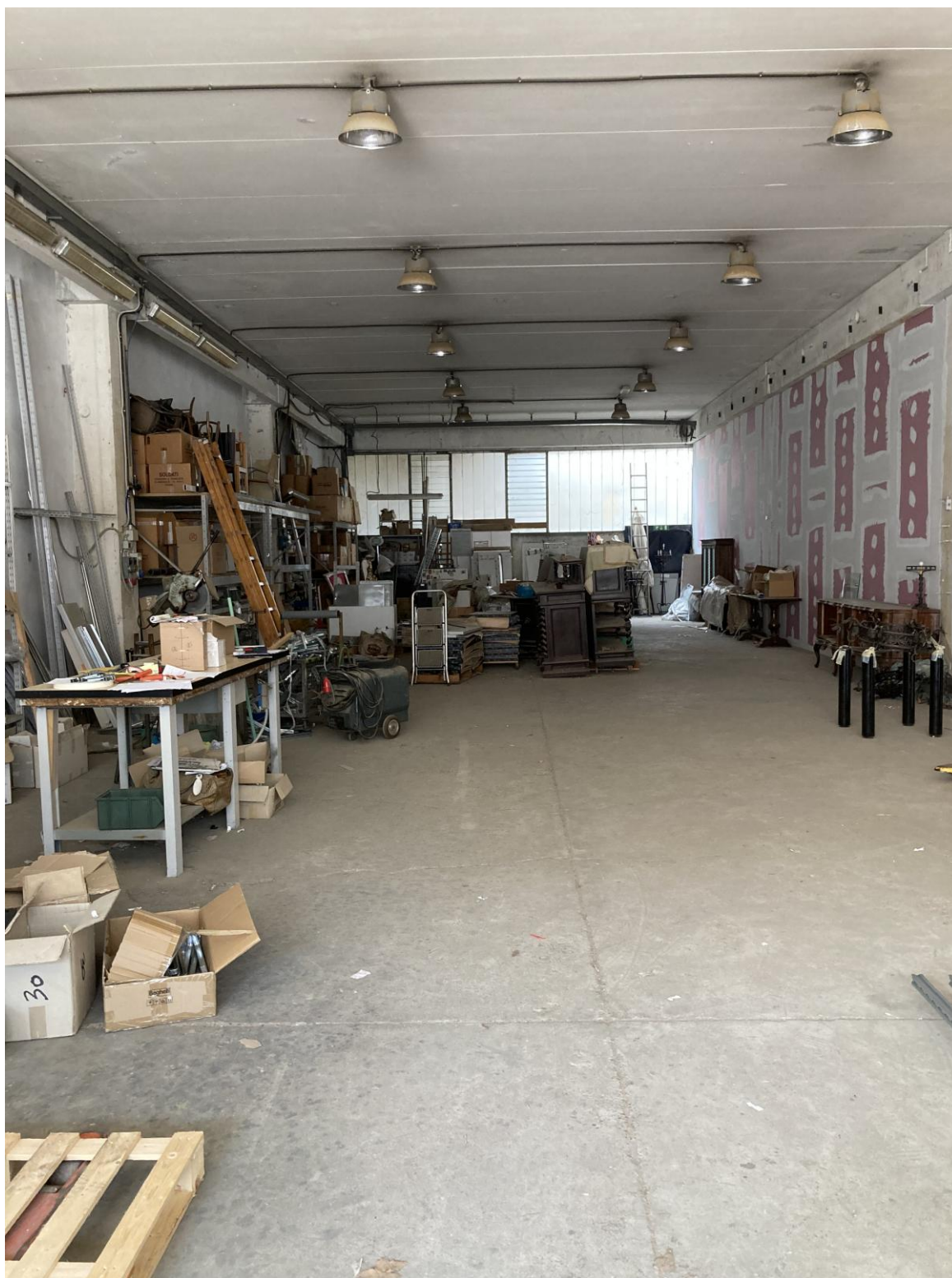
FOTO 10 –INTERNO VERSO LO SCANNAFOSSO (LOTTO A).
