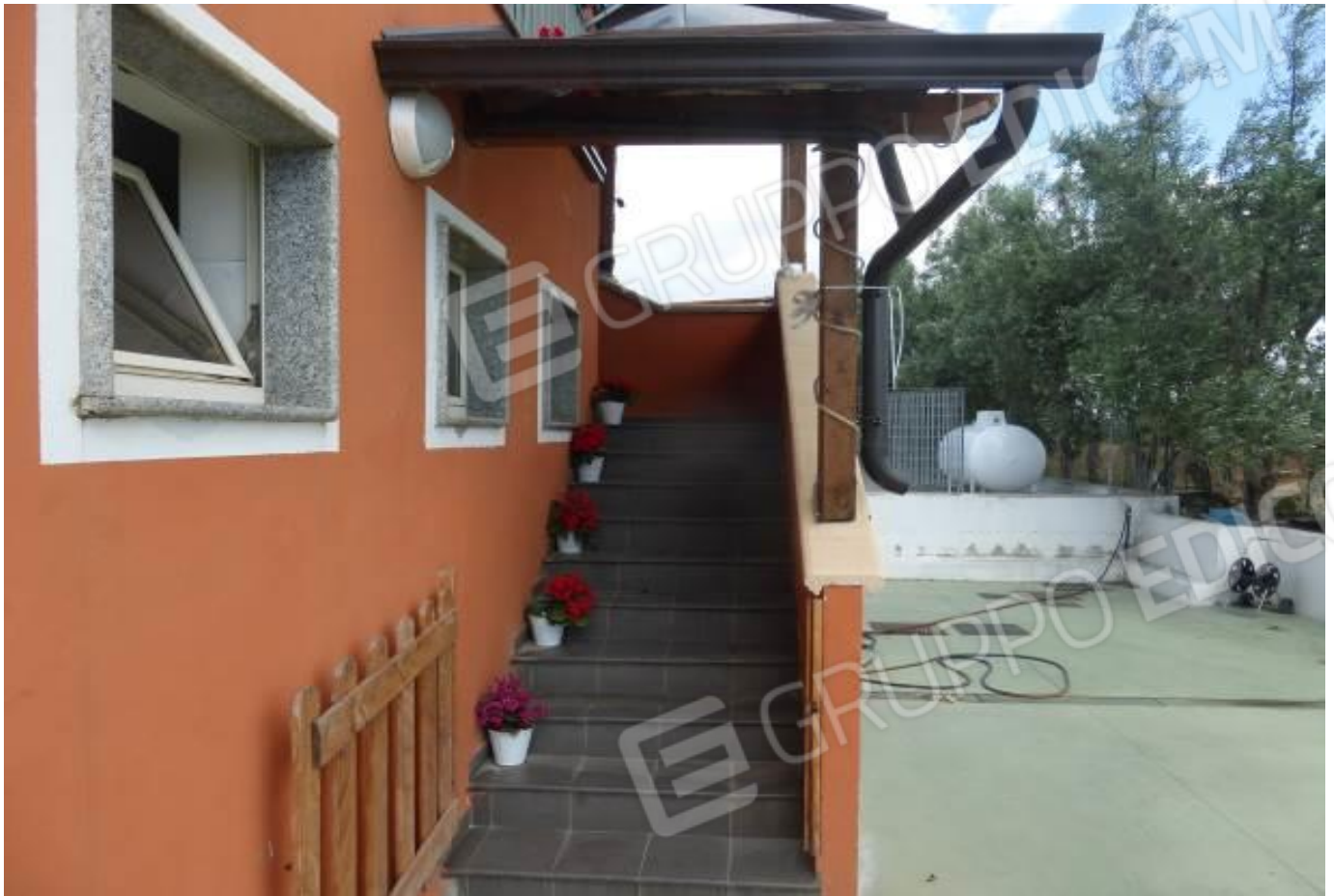
19) Lotti N°03/04_Corpo F – scala di accesso agli alloggi a P.1
