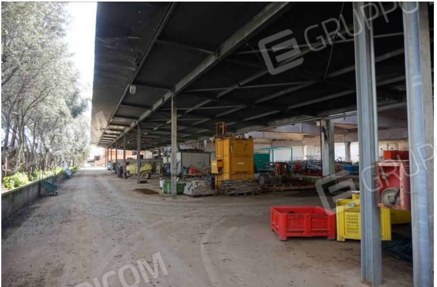
8) Lotto N°01_Corpo B - tettoia in profilati di ferro
