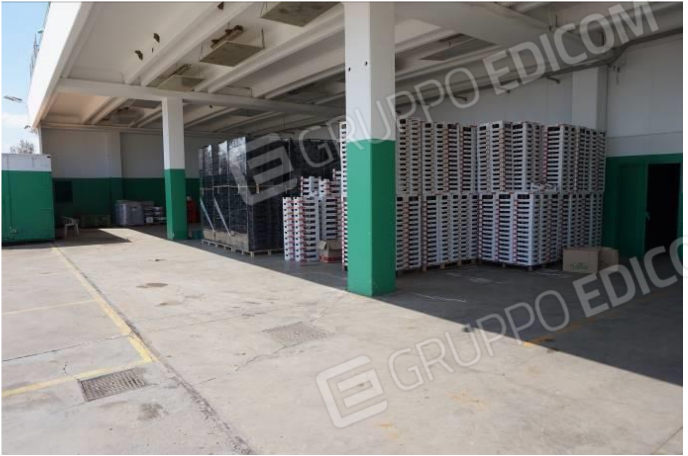
9) Lotto N°01_Corpo C - tettoia di elementi in c.a.p.
