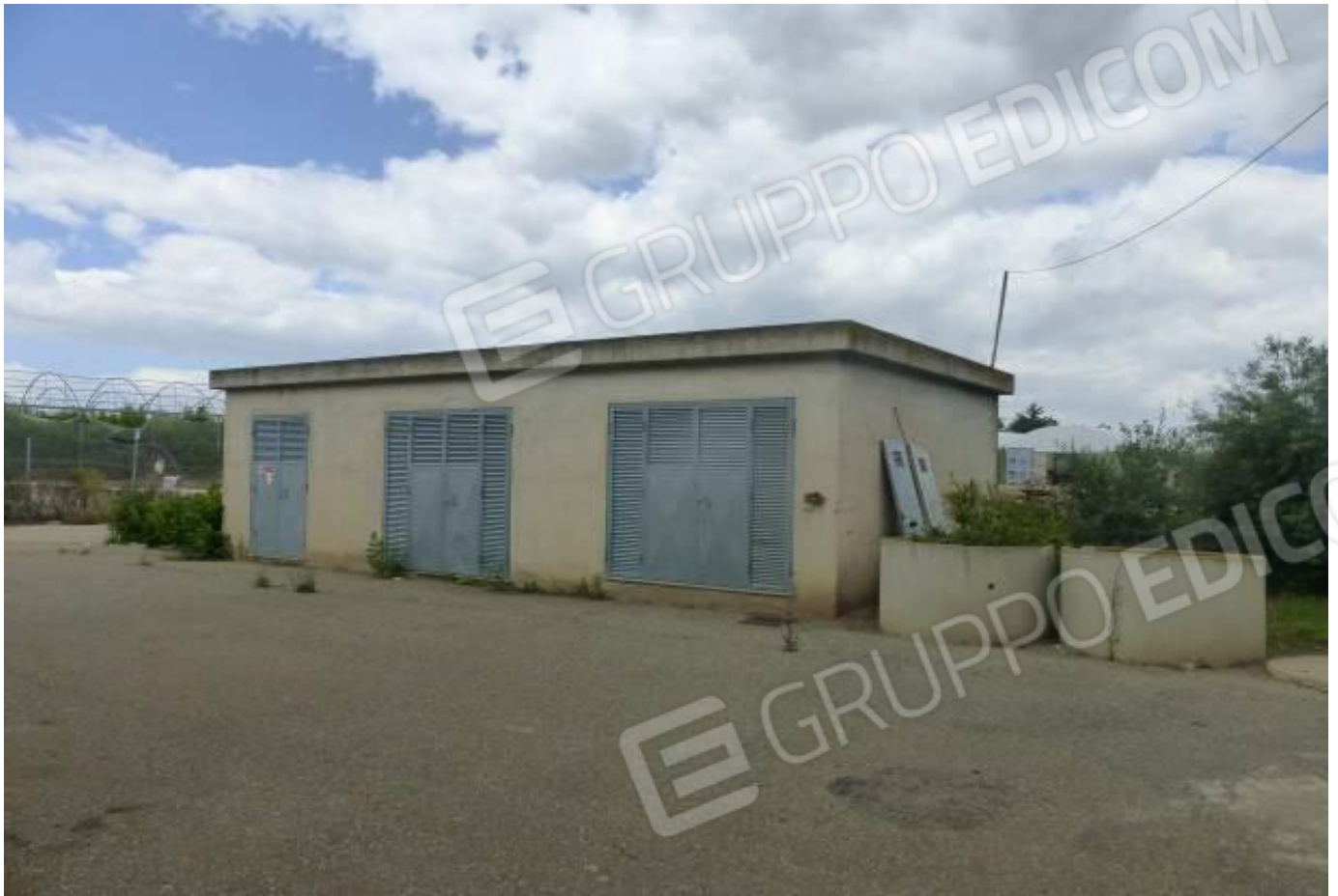
11) Lotto N°01_Corpo E - cabine tecniche per impianti
