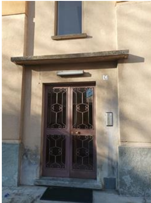
Ingresso condominiale scala C
