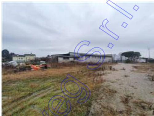
vista porzione Sud (canaletta)
