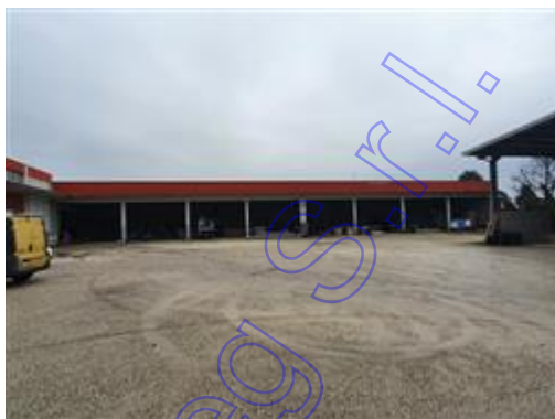
tettoia mezzi e attrezzi
