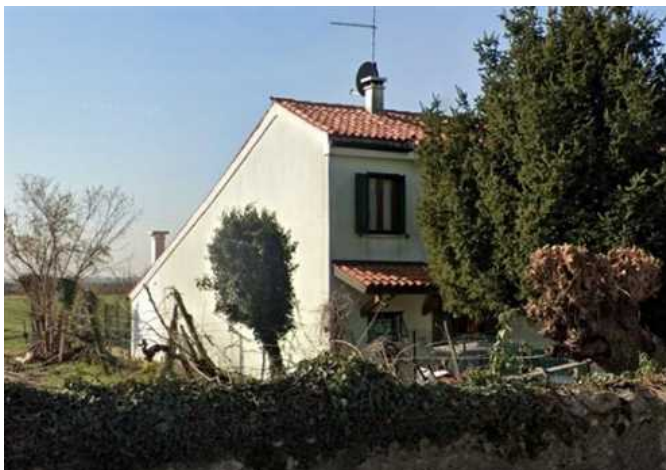
Vista del fabbricato da Nord-Est
