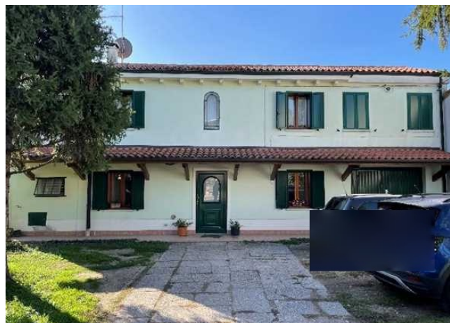
Vista del fabbricato da Nord
