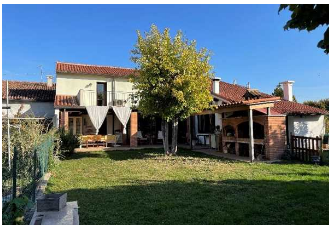
Vista del fabbricato da Sud
