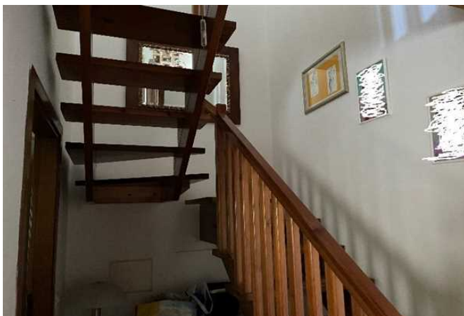
Vista della scala interna in legno
