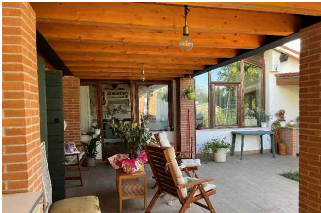
Vista del portico
